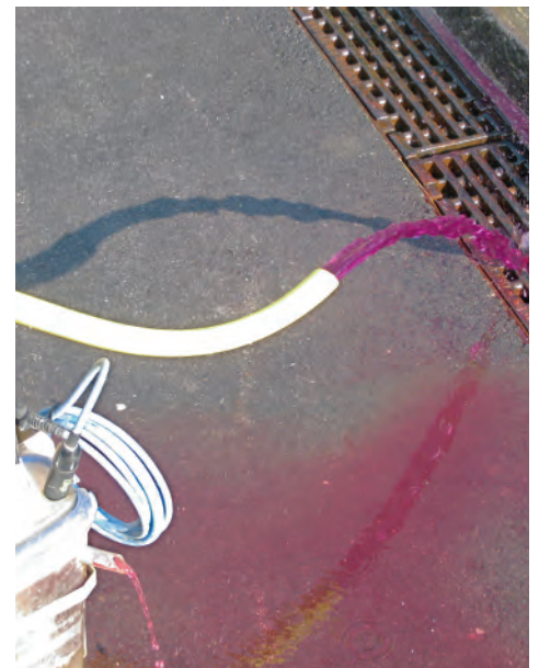
Grundwassersanierung bei Lyss (BE): Statt den verseuchten Boden auszuheben, wird Natrium-Permanganat in den Schadenherd gepumpt. Das Oxidationsmittel wandelt das giftige Perchlorethylen (Per) in harmlose Endprodukte um. Die Probeentnahme (Bild links und Mitte: Installation und Vorbereitung) bringt das violette Oxidationsmittel wieder zum Vorschein (Bild rechts).
