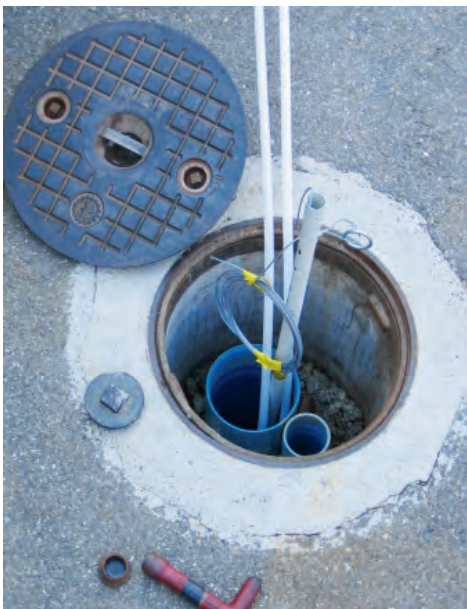
Grundwassersanierung bei Lyss (BE): Statt den verseuchten Boden auszuheben, wird Natrium-Permanganat in den Schadenherd gepumpt. Das Oxidationsmittel wandelt das giftige Perchlorethylen (Per) in harmlose Endprodukte um. Die Probeentnahme (Bild links und Mitte: Installation und Vorbereitung) bringt das violette Oxidationsmittel wieder zum Vorschein (Bild rechts).
