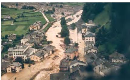
Gilt es zu verhindern: Grosse Überschwemmung im Poschiavo 1987 wegen Geschiebeeintrag (Quelle: Tiefbauamt Graubünden 1987)
