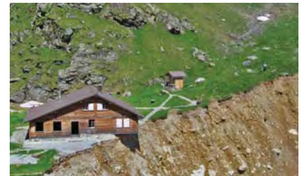
Stiereggütte bei Grindelwald im Jahr 2005. Abschmelzender Permafrost reduziert die Stabilität der Hänge, was u.a. an Gebäuden und Infrastruktur grosse Schäden anrichten kann. (Foto: Hansruedi Burgenet, 2005, http://www.planat.ch/de/hauseigentumeeer/ )
