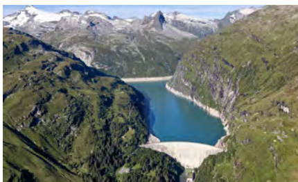
Die Wasserkraft kann kurz- bis mittelfristig vermutlich vom Klimawandel profitieren (Quelle: Mombelli 2012)
