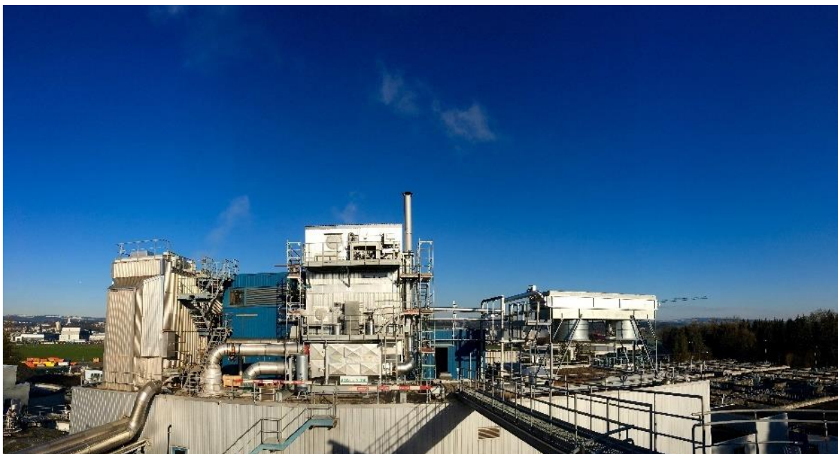
Bild der RTO Anlage (Regenerativ Thermische Oxidation) auf dem Dach der Klärschlammverbrennung
