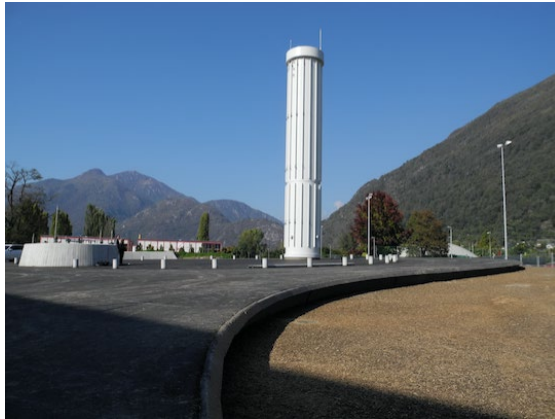
Abbildung 1: Kamin des unterirdischen Heizwerks in Losone.
