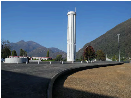
Bild 1: Kamin des unterirdischen Heizwerks in Losone.
