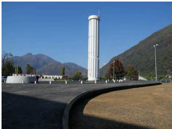
Bild 1: Kamin des unterirdischen Heizwerks in Losone.
