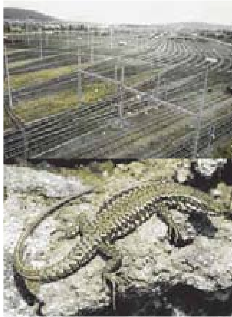
Gleisareal im Überblick
