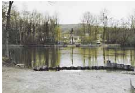
Neue Anlegestelle im Bau
