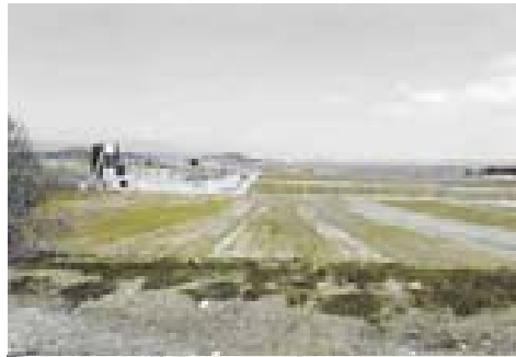
Teil des ehemaligen Perimeters, nach vollständigem Abbau und Rekultivierung
