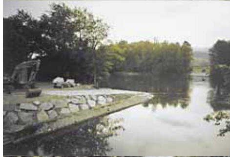
Die baulichen Veränderungen sind fertig, die Rampe bereit zur Installation.
