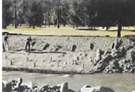
Génie biologique: renforcement des berges par boutures de saules.
