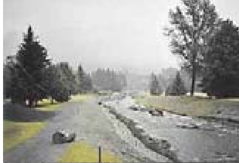
Les berges sont aplanies et renforcées au moyen de techniques de génie biologique.
