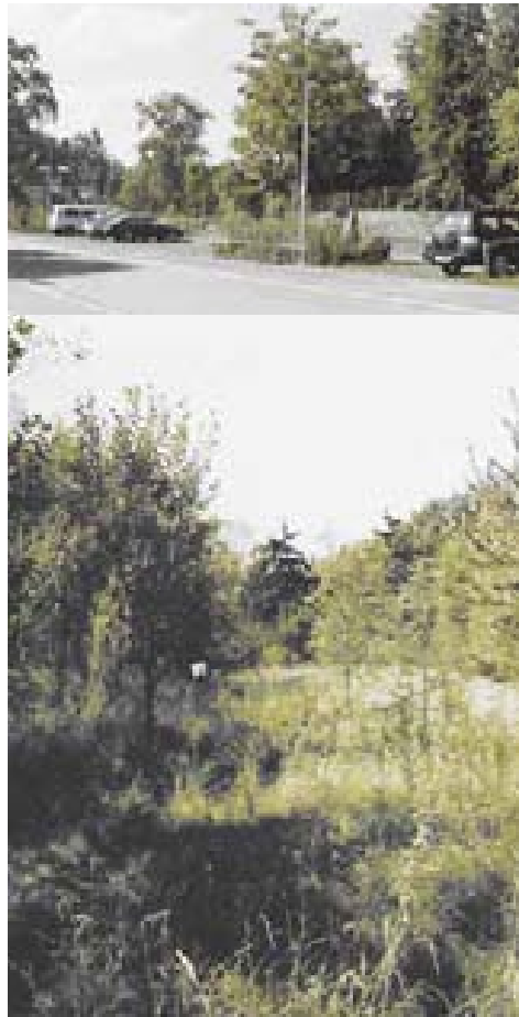
Die fertig gebaute Station fügt sich am neuen Ort gut ins Gelände ein
