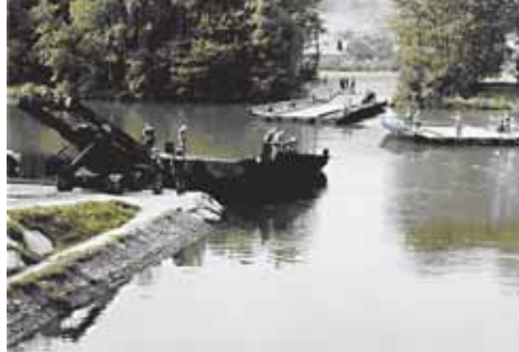
Die Brücke wird eingebaut.
