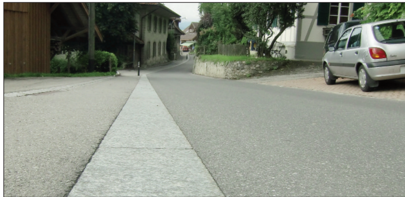
Abb. 7: Dorfstrasse, Granitband (niveaufrei)
