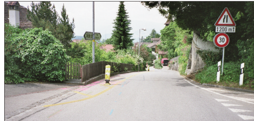
Abb. 3: Dorfstr./ Sädelstr., provisorische Fussgängerlängsmarkierung
