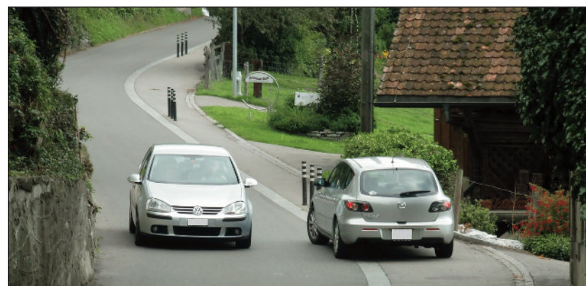
Abb. 10: Dorfstrasse, Begegnungsfall Pw - Pw
