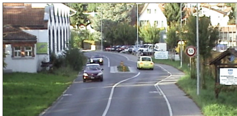
Abb. 9: Hauptstrasse, Ortseingang Süd mit Eingangspforte
