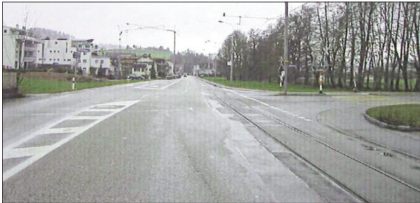
Abb. 15: Hauptstrasse Vorherzustand, Knoten K208/ K230 (Quelle: Metron AG)
