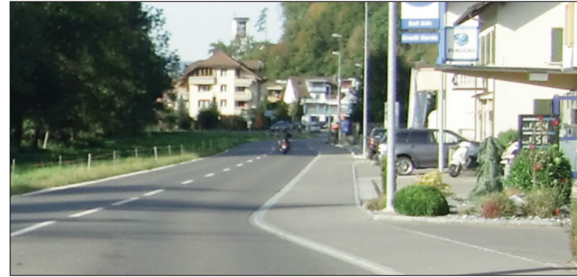
Abb. 14: Hauptstrasse IST-Zustand, Abschnitt 2
