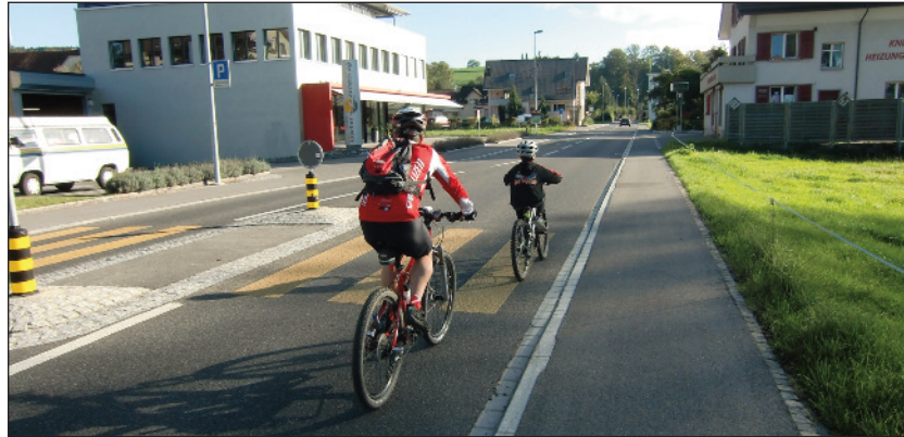
Abb. 10: Hauptstrasse, neuer Fussgängerstreifen mit Mittelinsel
