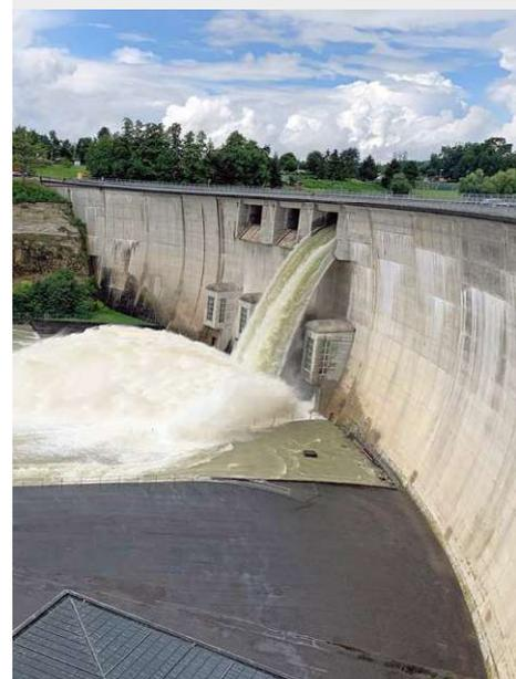
Hochwasserentlastung an der Staumauer des Schiffenensees. Bei hohen Zuflüssen der Saane ist das Speichervolumen der Stauseen viel zu gering, um die Wassermassen im Gebiet zurückzuhalten.
