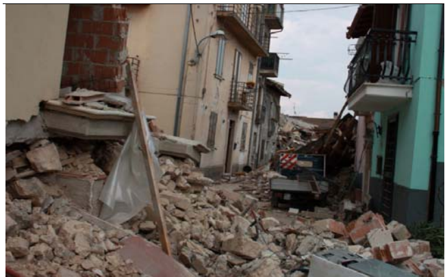
Beschädigte Gebäude müssen rasch auf ihre Bewohnbarkeit überprüft werden.
