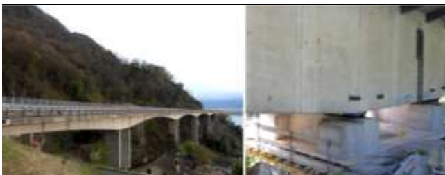
Erdbebensicherheitsmassnahmen, Viadukt Chillon (Bild T. Wenk)
