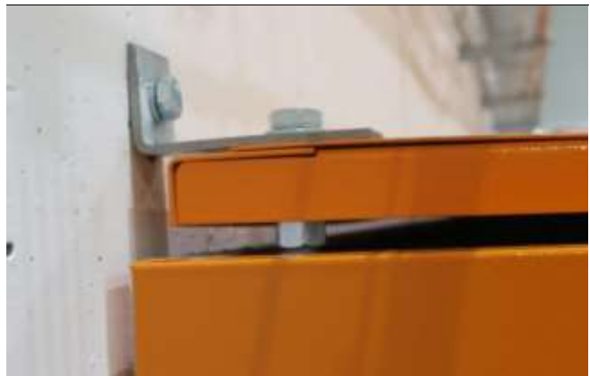
Sicherung eines Schrankes (Bild BAFU)
