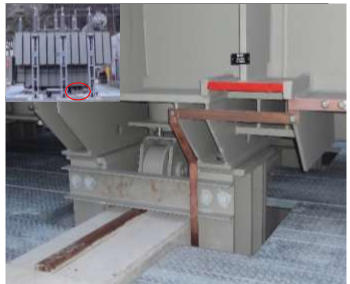
Verankerung eines 110 kV Transformators (Bild Axpö)
