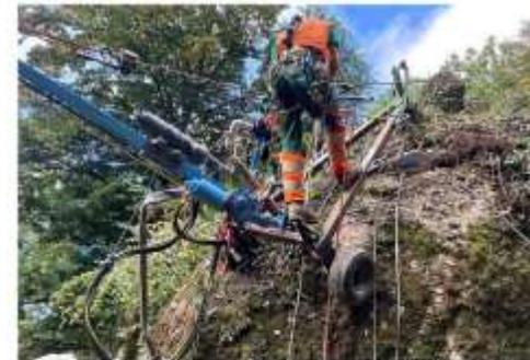
Les tiges métalliques permettent d'ancrer les masses instables de rochers.
