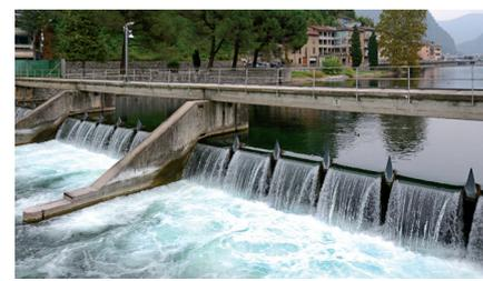
Das Regulierwehr von Ponte Tresa besteht aus drei Stauklappen von je 14 Meter Länge, die mittels Zylindern bewegt werden. Der durchschnittliche Höhenunterschied des Wasserstandes ober- und unterhalb des Wehrs beträgt zwischen 1,5 und 2,0 Meter.
