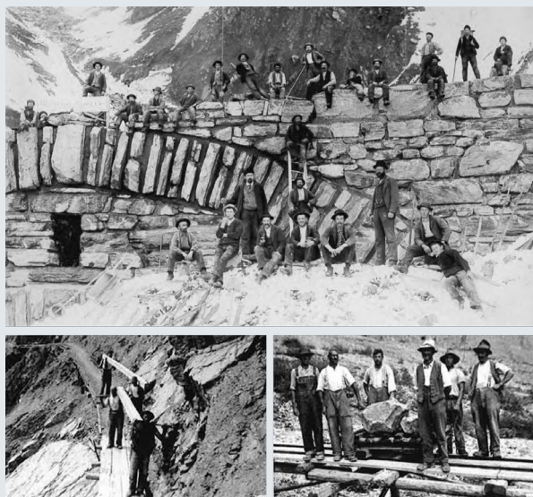
Abb. 32: Sperrenbau im Lammbach um 1900 (OIK I, 2009 aus [63])
