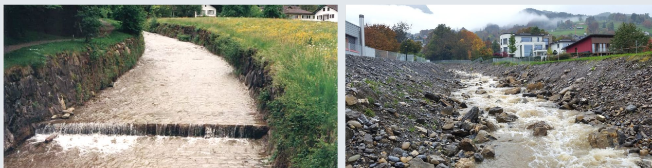
Abb. 30: Bauliche Massnahme am Steinibach b. Hergiswil vom Funktionstyp «Durchleiten»
