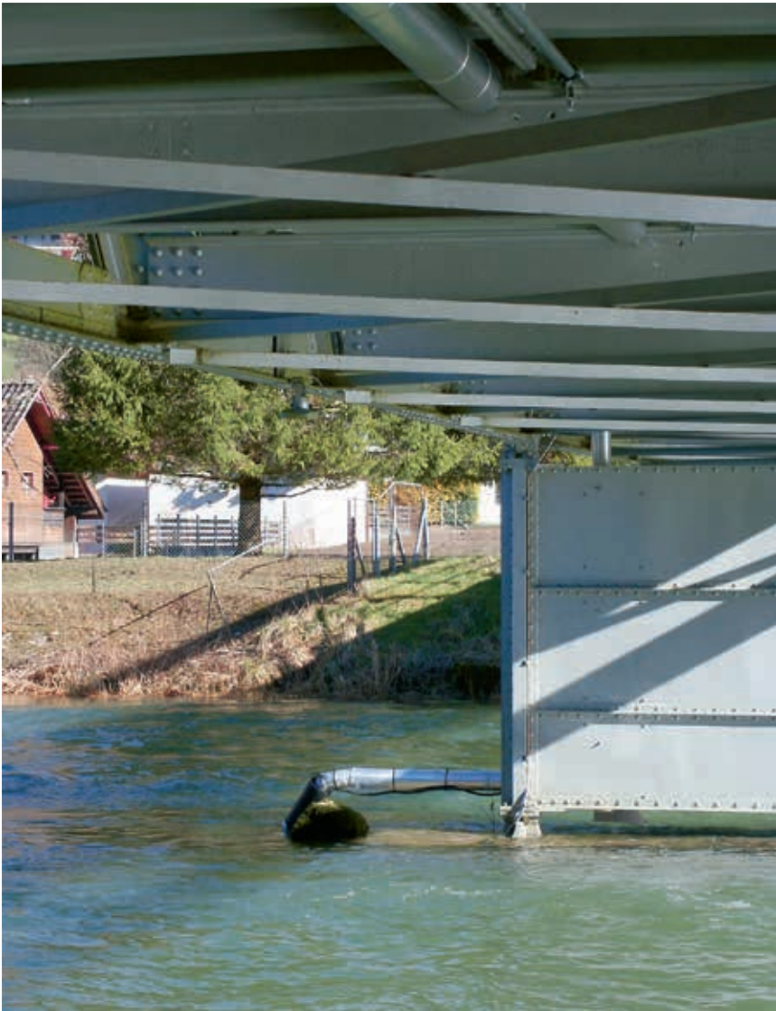
Karim Michel (rechts) von der BAFU-Abteilung Hydrologie demonstriert das technische Innenleben der neu ausgerüsteten Messstation (Mitte). Die kontinuierliche Wasserentnahme erfolgt mittels eines Rohrs, das unter der Doubs-Brücke in Ocourt montiert ist (links).
