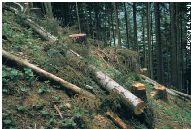
Abb. 7: Liegende Weisstannen in Pfäfers. Zuerst wurde der normale Holzschlag durchgeführt (vor allem Fichten), das heisst die Bäume wurden gefällt und mit dem Seilkran abgeführt. In einem zweiten Arbeitsschritt wurden die vorher markierten Weisstannen gefällt und diagonal zur Falllinie deponiert. Diese Baumstämme sollen helfen, die Steine zu bremsen.
