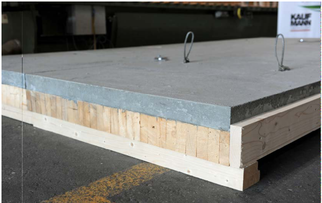
Abb. 18: Holz-Beton-Verbund vorgefertigt mit Fichtenlamellen
