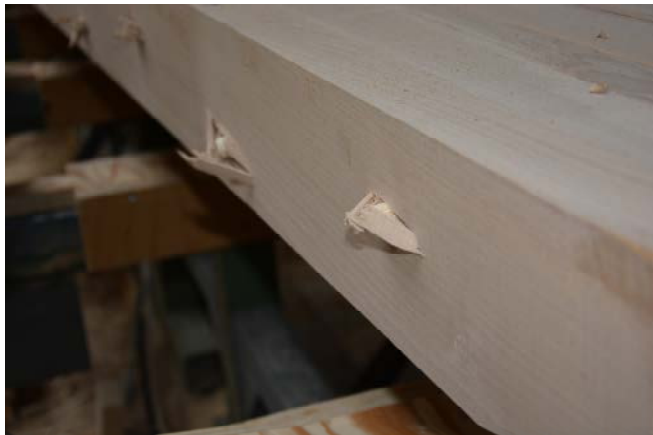
Abb. 9: Rückseite nach Einschub der Dübel, vor dem Model hobeln
