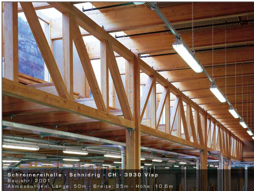
Abb. 3-20: Werkhalle mit BSH-Trägern aus Esche der Neuen Holzbau AG (Neue Holzbau AG)
