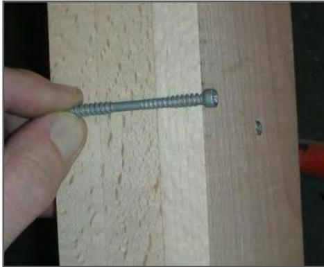
Abb. 3-23: Triobalken für das Bauernhaus bei Neuenegg mit neu entwickelter Schrauben (Gautschi 2009)
