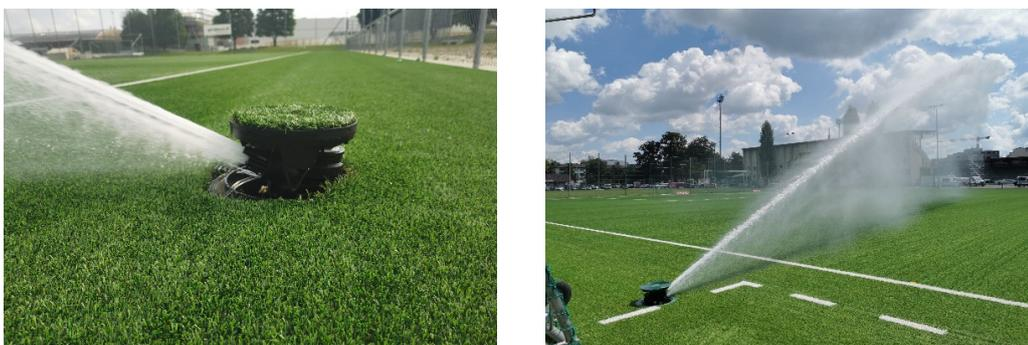
**Abbildung 4:** Beregnung der Kunststoffrasenplätze mittels installierter Anlagen.
