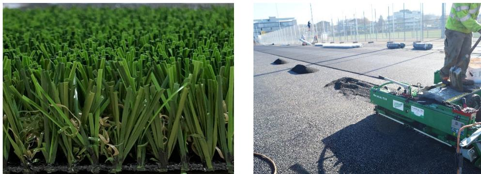
**Abbildung 2:** Unverfüllter Rasenteppich (links) und Ortseinbau einer Elastikschicht (rechts).
