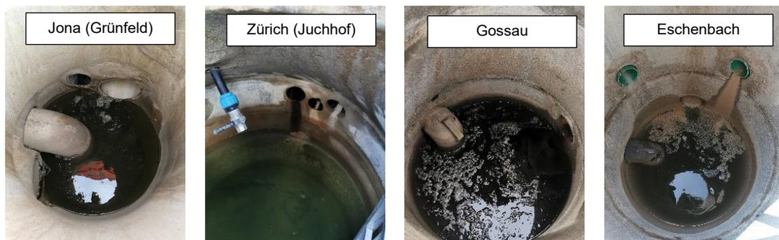
**Abbildung 5:** Einleitungen von Sickerwasser in Sammelschächte von Kunststoffrasenplätzen.
