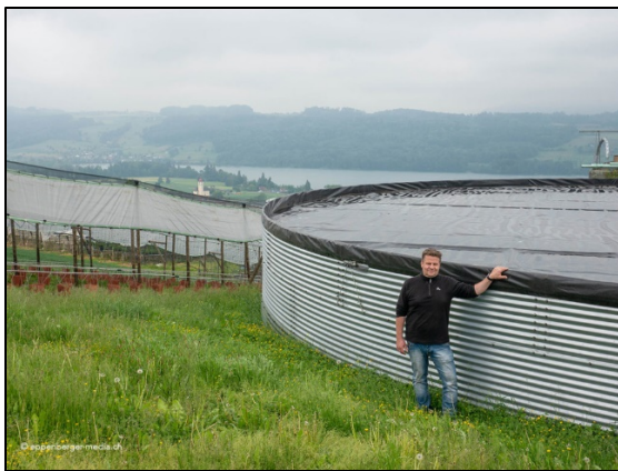
Abbildung 6: links: Stahlsilo bei einem Beerenproduzenten in Aesch LU mit 805 m 3 Speicherkapazität (Eppenberger 2020); rechts: zwei kleinere Teiche klären das Wasser, bevor es in den grossen Bewässerungsspeicher (20.000 m 3 ) fliesst, Gemüseproduzent in Deutschland (Foto: (Deter and Eghbal 2020) bioland-Fachmagazin).
