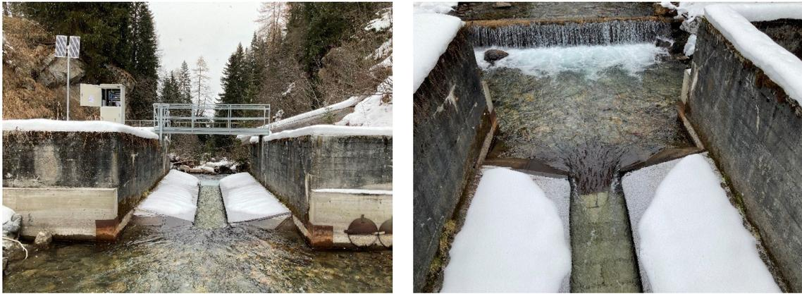
Abbildung 1: Messstation am Dischmabach bei niedrigem Abfluss im Winter; links: Blick von oberhalb der Messstation in Flussrichtung; rechts: Blick von der Brücke aus nach stromaufwärts auf den Zulaufbereich und die Schwelle. Quelle: BAFU
