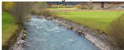
undurchlaessig verbaut, steil
