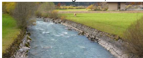
undurchlaessig verbaut, steil
