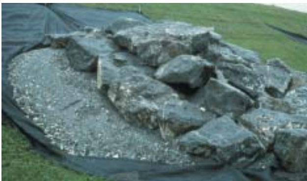
Sicherung gefährdeter Dämme an der Rhone als wichtige Notmassnahme im Oktober 2000.
