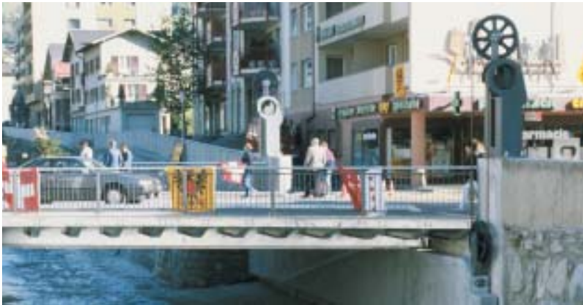
Risikomanagement in Brig: Diese automatische Hebebrücke entschärft die Hochwasser-Gefahr durch die Saltina.
