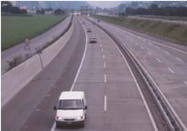
Hochwasserschutz-Massnahme im Kanton Uri: Führt die Reuss zuviel Wasser, so dient die Autobahn als zweites Flussbett. Dies verhindert Schäden im Siedlungsgebiet wie 1987.
