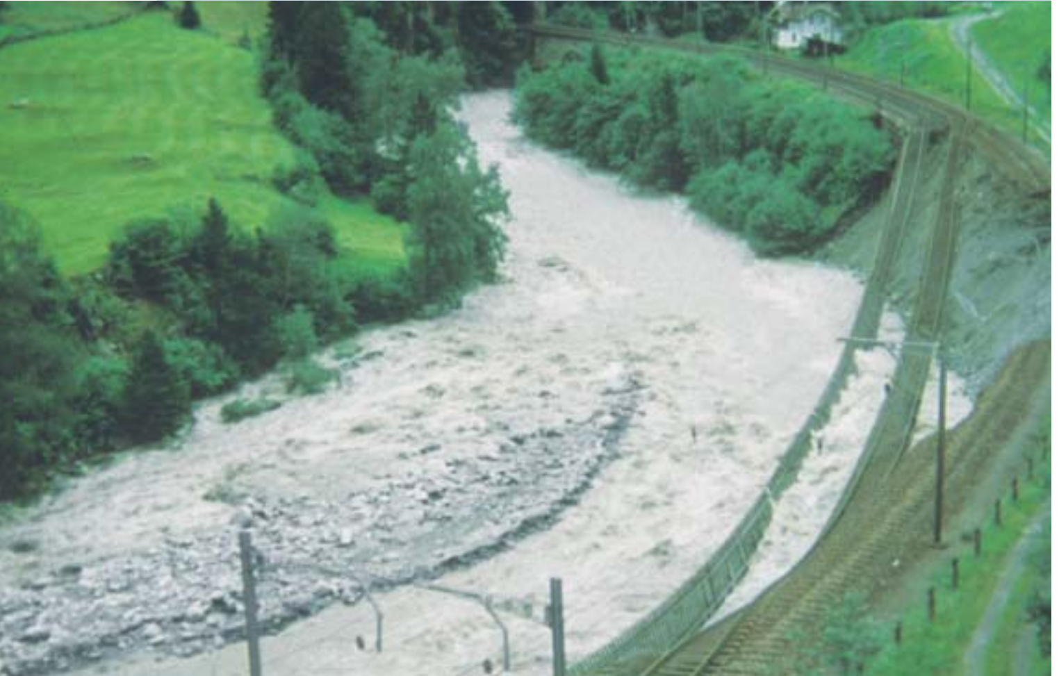
Unterbrechung der Gotthard-Bahnlinie im Kanton Uri durch Ufer-Erosion der hochgehenden Reuss im August 1987.
