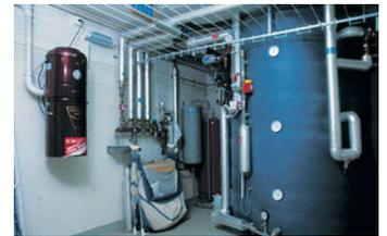
Warmwasser: 2200 Liter Kombispeicher, 80% durch Sonnenkollektoren, 20% durch Elektroheizstab
