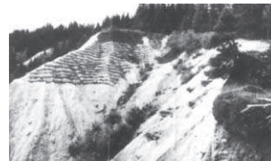
Abb. 3: Bau der Heckenbuschlagen in der Blaike Geroldsbach 1955
