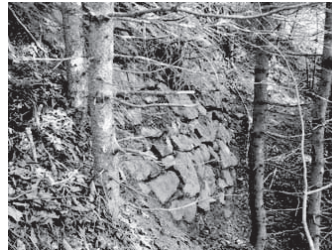
Abb. 10: Stabile Trockensteinmauer als Stützelement
