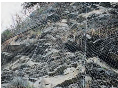
Les recouvrements par filet ancré protègent les voies de communication des chutes de pierres.
