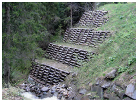
Des seuils en béton réduisent la force érosive de l'eau des torrents.
