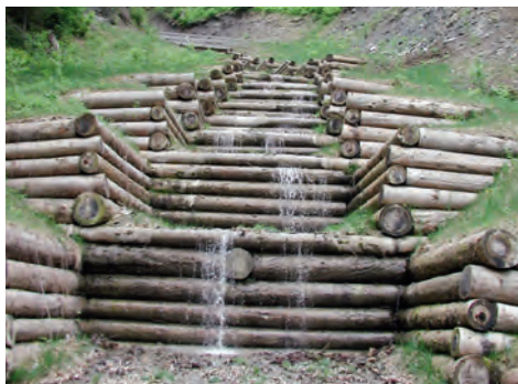
Des barrages en bois montés en escalier freinent la vitesse d'écoulement de l'eau.
