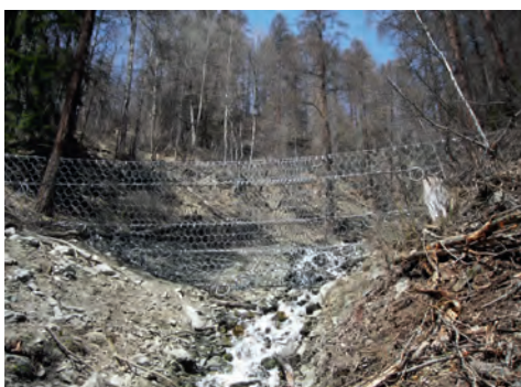
Les filets à anneaux retiennent les laves torrentielles et protègent routes, voies ferrées et villages.
