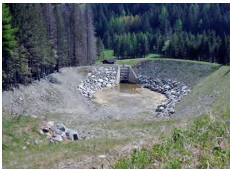
Les dépotoirs retiennent les alluvions et réduisent ainsi le risque d'inondation dans les villages situés en aval.
