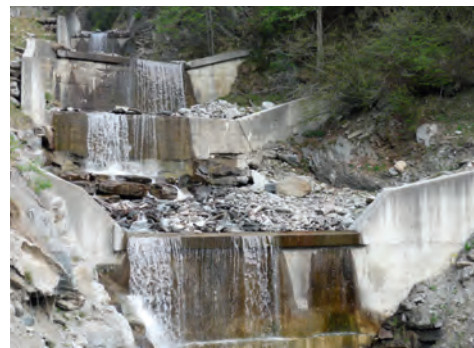
Des seuils en béton réduisent la force érosive de l'eau des torrents.
