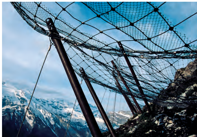
Les filets à neige ont la même fonction que les tabliers en acier, mais résistent mieux aux chutes de pierres.
