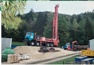
Forage de reconnaissance pour le captage de la nappe d'eau souterraine profonde de Sonvilier.
