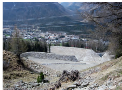
Les digues de protection peuvent retenir les chutes de blocs rocheux.
