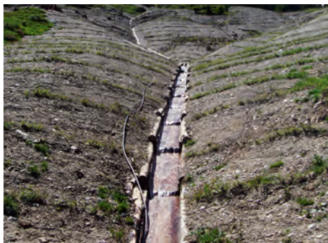
Des barrages en bois montés en escalier freinent la vitesse d'écoulement de l'eau.
