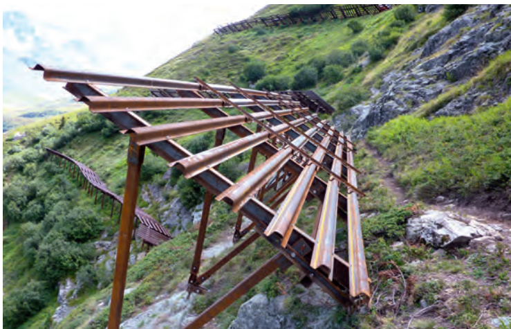
Des ouvrages permanents en acier stabilisent le manteau neigeux et empêchent que des avalanches se déclenchent sur les versants escarpés.
