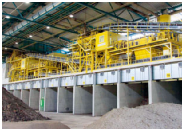
A Oberglatt (ZH), au centre BAZO de traitement des sols contaminés, les déchets sont prétraités dans une halle fermée en vue de leur élimination ultérieure.
