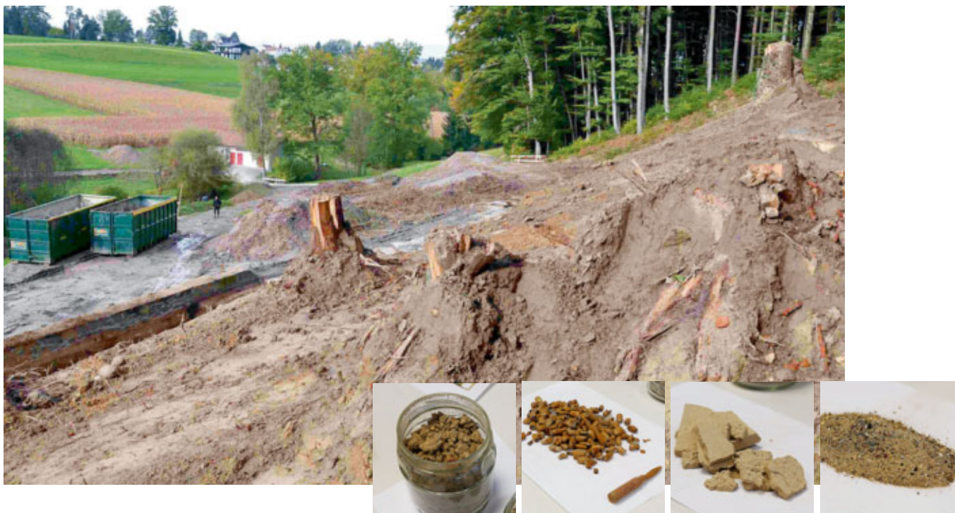
Assainissement du stand de tir de Guin (FR). Petites photos (de gauche à droite): terre contenant du plomb, extraction de balles en plomb, gâteaux de filtration, terre nettoyée
