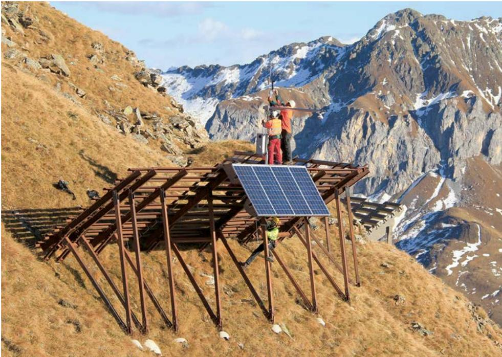
**A Sankt Antönien (GR), une des plus grandes centrales solaires de Suisse doit être construite sur 12 kilomètres d'ouvrages paravalanche. Sur la photo: montage d'une installation d'essai.**
