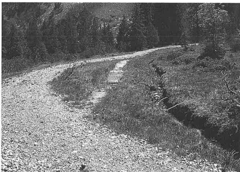
Fig. 7: Nouvelle construction d'une piste à machines consolidée à travers un biotope de haut-marais (ancien chemin en rondins au milieu de la photo). L'apport de calcaire à partir de l'empierrement et des drainages latéraux cause des atteintes au marais des deux côtés du chemin. Photo: Hintermann & Weber AG
