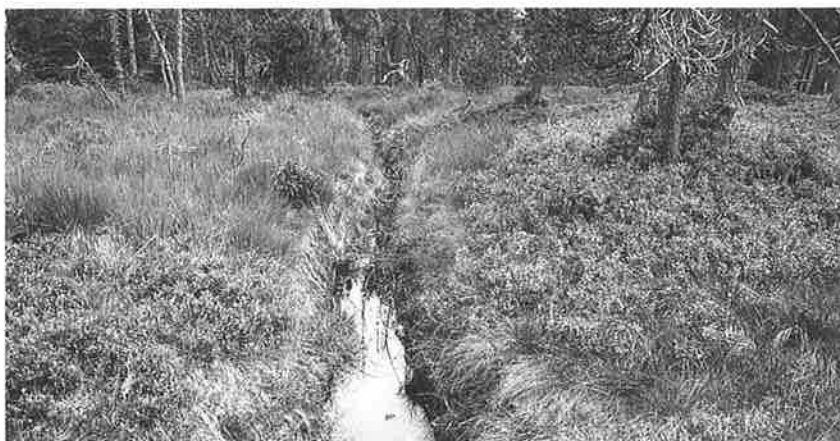
Fig. 1 : Effet de drainage minimal de fossés ouverts (Wängenschliere, Alpnach) Photo: B. von Wyl
