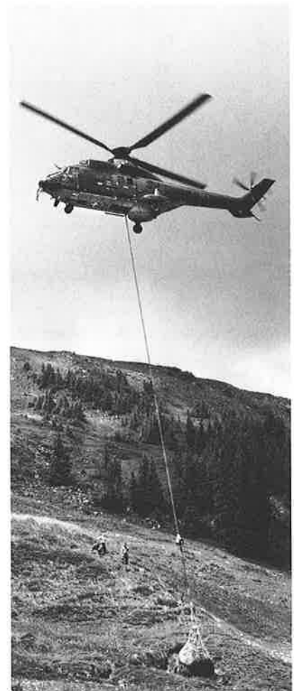
Fig. 1: Un hélicoptère transporte un caisson contenant une installation de ciblerie automatique préfabriquée jusqu'au chantier. Photo: E. Suter
