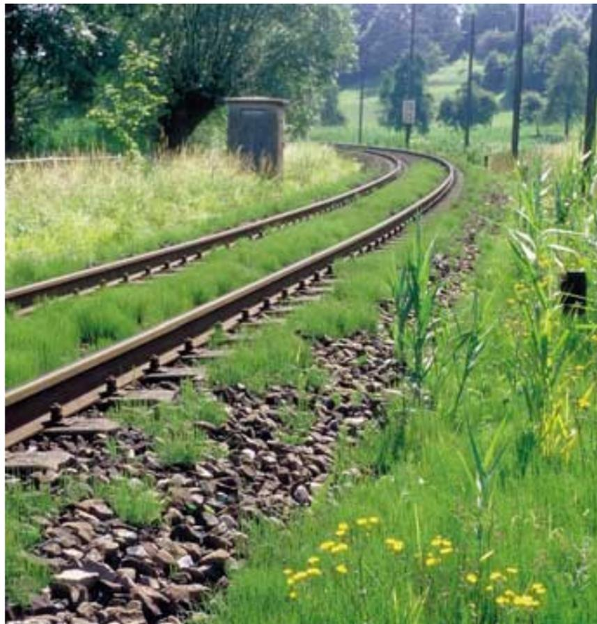
*Des voies envahies par la végétation peuvent porter atteinte à la sécurité de l'exploitation ferroviaire. La prolifération des plantes doit être contrôlée par des mesures adaptées aux conditions locales et aux exigences de la voie.*
