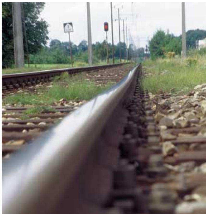
Les plantes sont des indicateurs parfaits de la structure du sol: sur cette photo, la prolifération des prèles montre que le sol, à cet endroit, est humide et, par conséquent, instable – d'où l'affaissement de la voie.
