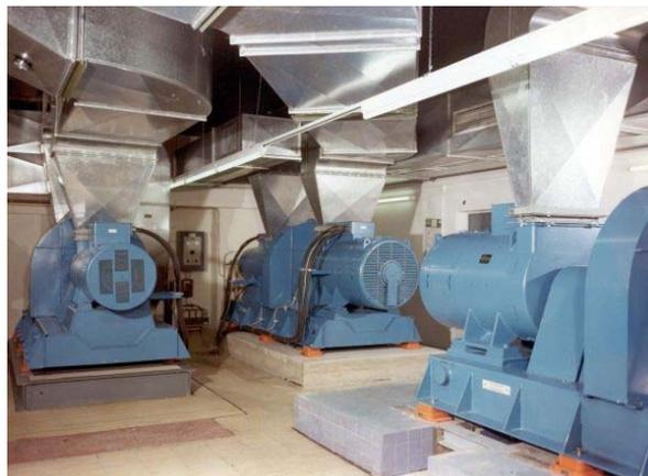
Fig. 13: Isolation vibratoire d'une installation de ventilation à l'aide d'amortisseurs à ressorts (<http://www.gerb.com>).
