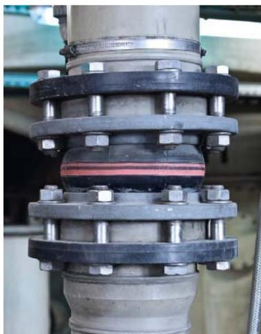
Fig. 8: Manchon souple en caoutchouc (<http://www.ditec-kt.de>).
