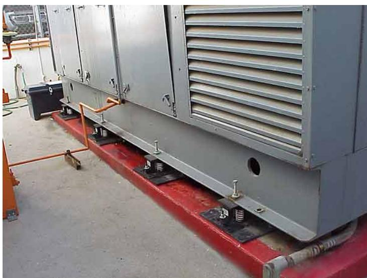
Fig. 20: Isolation sismique d'un générateur de secours (<http://www.etccd.com>).
