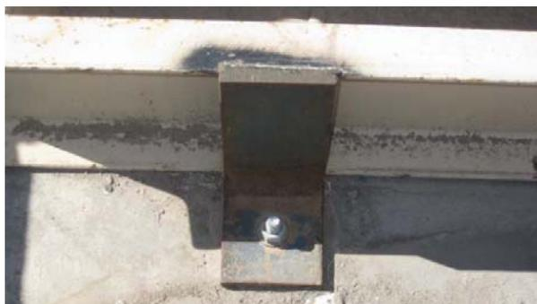
Fig. 11: Ancrage anti-basculement d'un groupe frigorifique sur les fondations: il s'est révélé efficace lors du séisme survenu en 2010 à Mexicali (Hutchinson et al. 2010).
