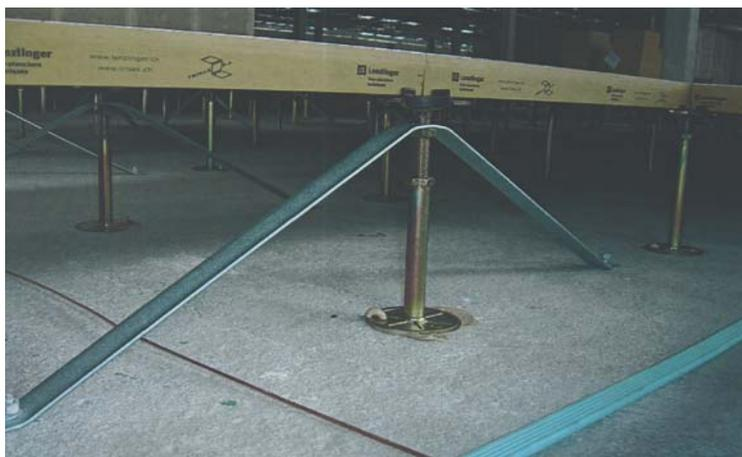
Fig. 17: Fixation parasismique d'un plancher surélevé.
