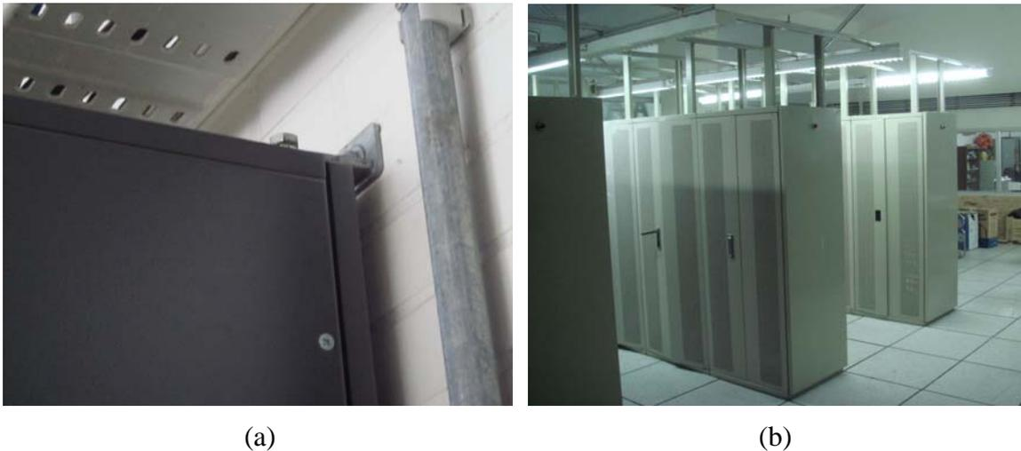
Fig. 15: Ancrage d'armoires électriques: a) sur un mur porteur (photo Weber) et b) au plafond dans le cas d'armoires isolées (photo Studer).
