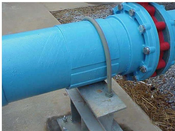
Fig. 2: Fixation solide à l'aide d'un étrier (ALA 2002).
