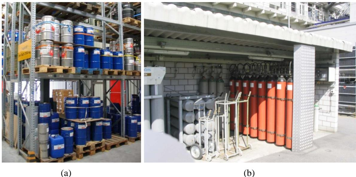
Fig. 21: Entreposage de marchandises selon les règles parasismiques: a) palettes et récipients attachés ensemble; b) bouteilles de gaz arrimées par des colliers métalliques (photo Studer).
