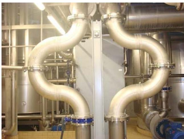
Fig. 9: Conduites souples avec lyres de dilatation (<http://www.z-montagen.ch>).
