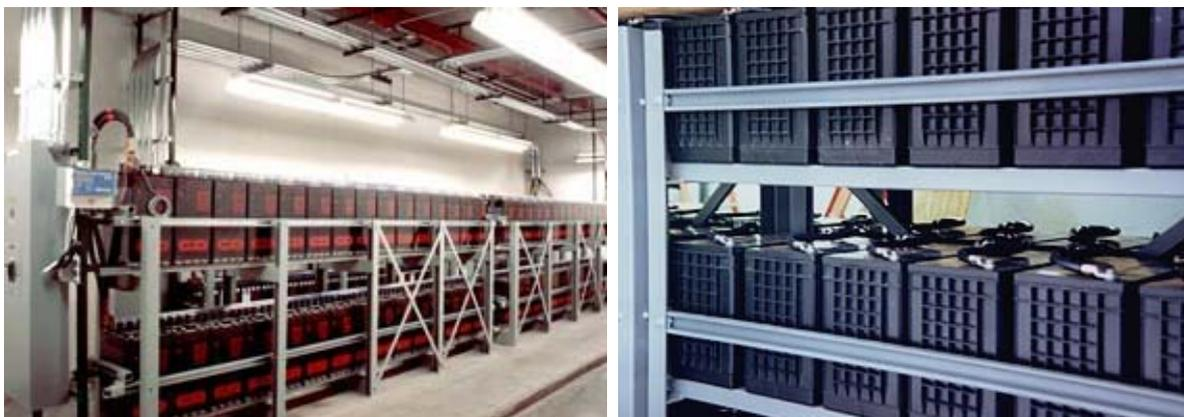
Fig. 19: Alimentation en courant sans interruption avec un système empêchant les accumulateurs de tomber et de se renverser (JMAEG, Phasor Corporation).
