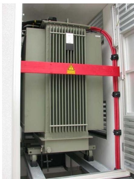
Fig. 18: Transformateur placé sur des rails et sécurisé pour ne pas rouler ou basculer.
