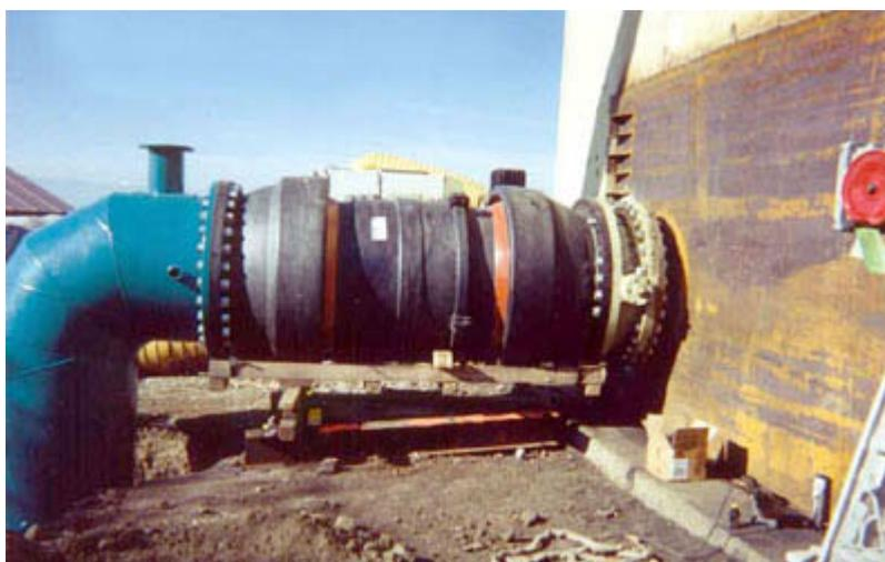
Fig. 6: Raccord souple sur un réservoir (<http://www.sccitanks.com>).
