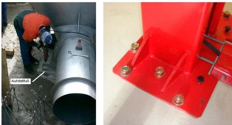
Fig. 10: Ancrage de récipients et de socles d'appareils (HB-Technik, Profitexx).
