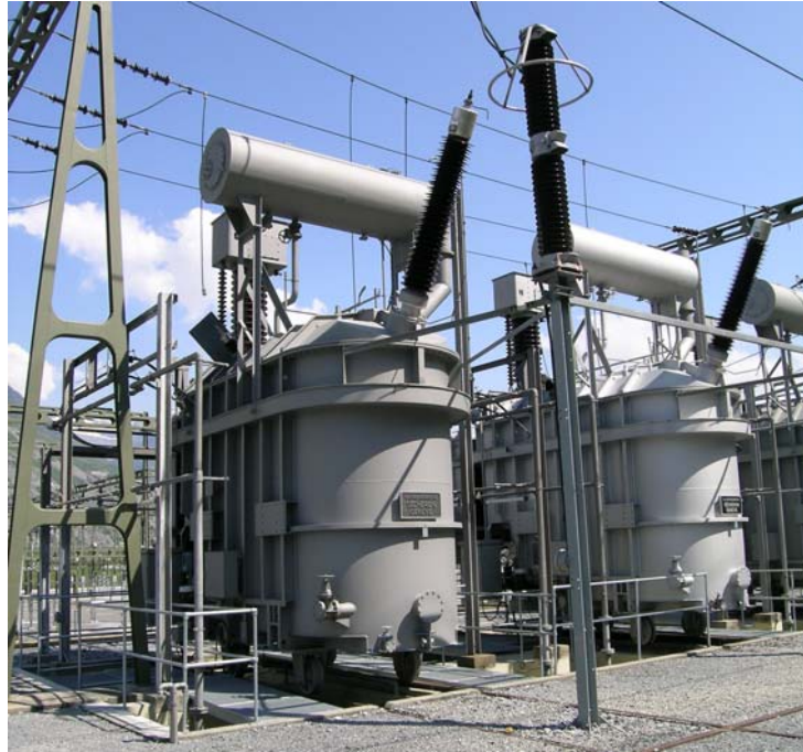
ill. 6.7 : Transformateur 220 kV/150 kV.
