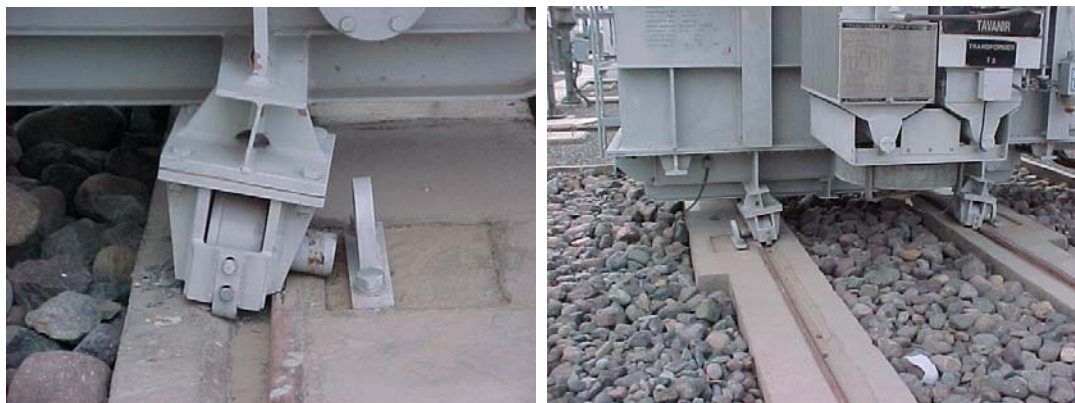
ill. 6.10 : Défaillance de l'ancrage insuffisant d'un transformateur 132 / 20 kV lors du tremblement de terre de Bam, Iran ( M_w = 6.5 ), 2003. (Photo: TREC, de [2]).
