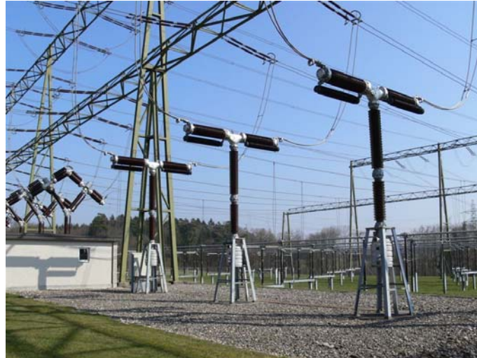
ill. 6.2 : Disjoncteur avec isolateurs en porcelaine pour 380 kV.
