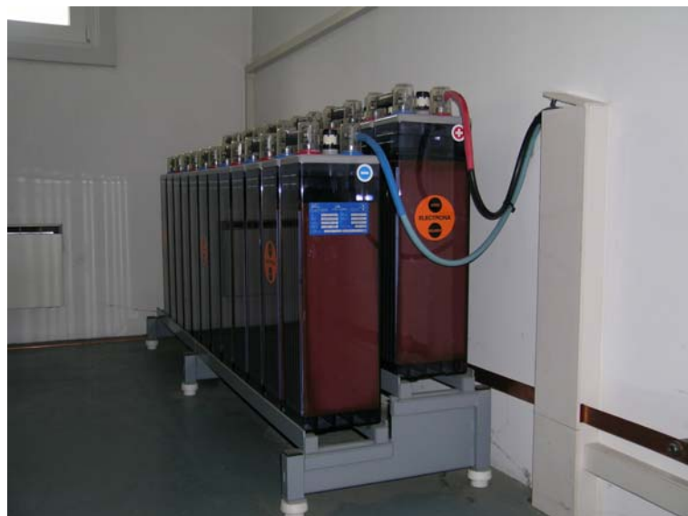
ill. 6.14 : Batteries hautes et étroites pour l'alimentation sans interruption de la sous-station de Chamoson : les batteries non sécurisées pourraient se renverser déjà lors d'un faible séisme, cf. ill. 3.4.
