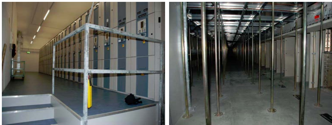
ill. 6.13 : Une installation à moyenne tension sur châssis, entourée d'un faux plancher (à gauche), sans contreventement contre les forces horizontales (à droite : vue sous le faux plancher) ; en cas de tremblement de terre, il y a risque d'effondrement.
