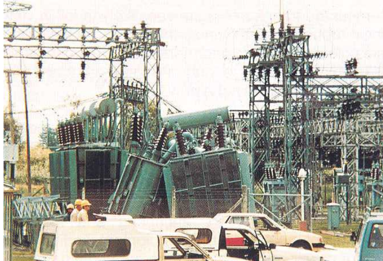
ill. 6.9 : Transformateurs renversés à cause d'un ancrage insuffisant lors du tremblement de terre d'Edgecumbe ( M = 6.3 ), 1987, en Nouvelle-Zélande. Photo : M.J. Pender, de [7].
