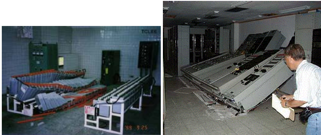
ill. 3.4 : Batteries et armoires de commande renversées dans la sous-station de Chungliào après le séisme de Chi-Chi ( M_w = 7.6 ), Taiwan, 1999 (photos : ASCE-TCLEE resp. EQE International Inc., de [2]).
