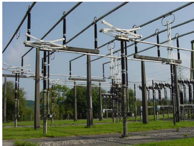
ill. 6.3 : Sectionneurs pantographe pour 220 kV en position « ouvert » (au premier plan) et en position « fermé » (à l'arrière plan).
