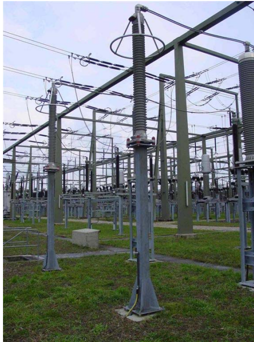
ill. 6.6 : Parafoudre pour 220 kV.
