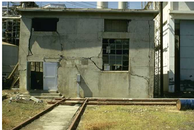
ill. 6.12 : Nicaragua, 1972 (M = 6.2) : Bâtiment pour systèmes secondaires peu avant l'effondrement ; un même type de dégâts est également possible en Suisse. Photo : K.V. Steinbrugge.
