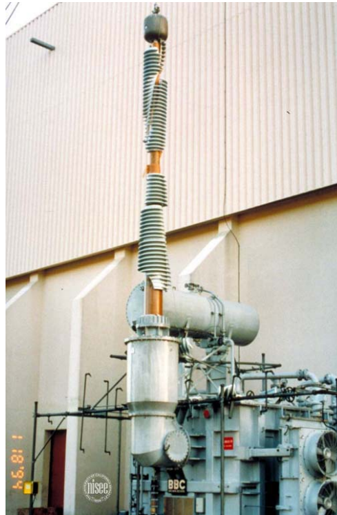
ill. 3.2 : Northridge, 1994 : traversé de transformateur qui a éclaté (500 kV).
