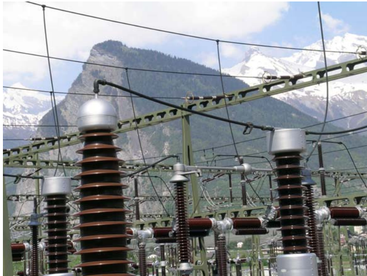
ill. 6.8 : Connexions tendues entre une boîte d'extrémité de câble et un transformateur de tension à Chamoson (220 kV).
