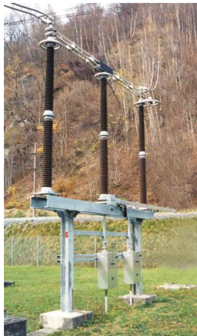
ill. 6.5 : Sectionneur rotatif avec sectionneur de terre pour 380 kV.
