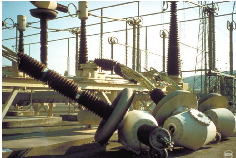
ill. 3.1 : Northridge, 1994 : disjoncteurs détruits 500 kV-SF6 des années 70, avec un centre de gravité extrêmement élevé.
