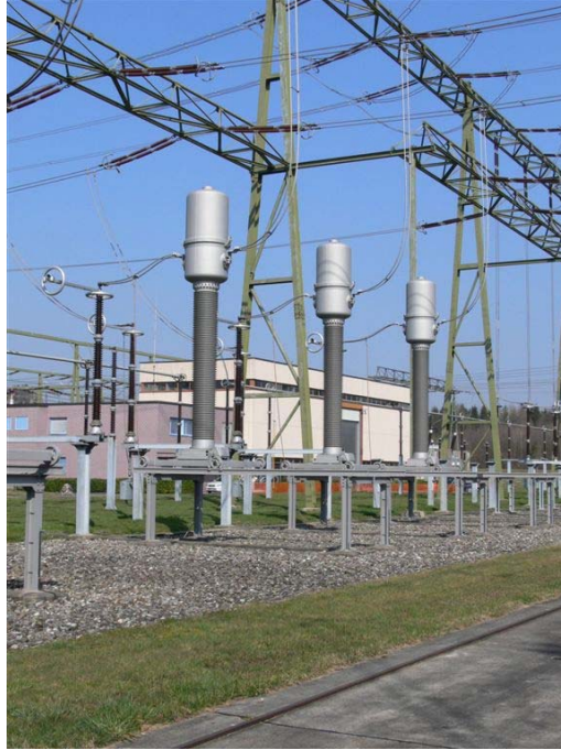
ill. 6.4 : Groupe de mesure pour 380 kV (transformateurs de courant et de tension combinés)
