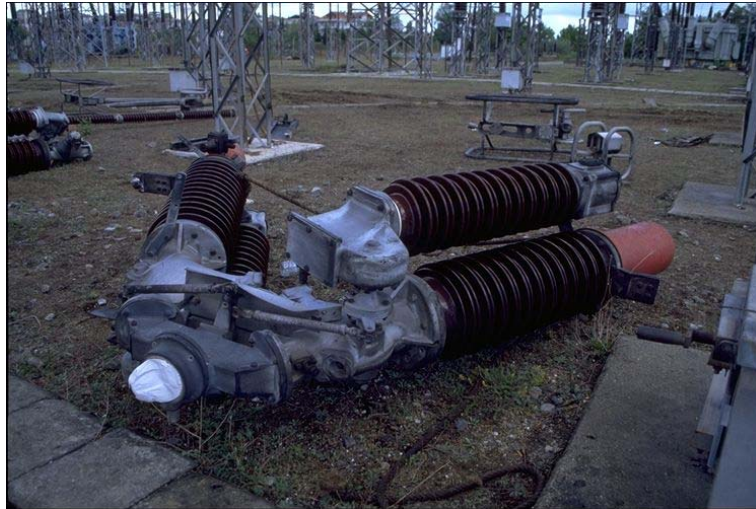
ill. 3.3 : Kocaeli, 1999 : disjoncteur avec centre de gravité très élevé, détruit dans une sous-station à Adapazari (niveau de tension inconnu) (photo : A.S. Whittaker).
