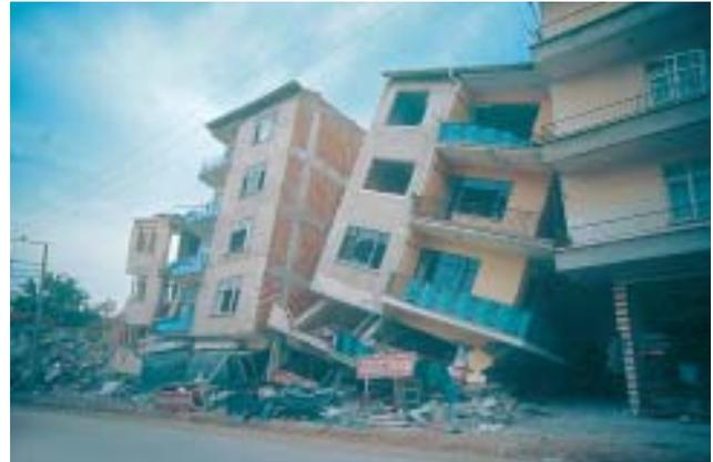
4/2 Les mécanismes de colonnes sont souvent inévitables lorsque le rez-de-chaussée est flexible (Izmit, Turquie, 1999).
