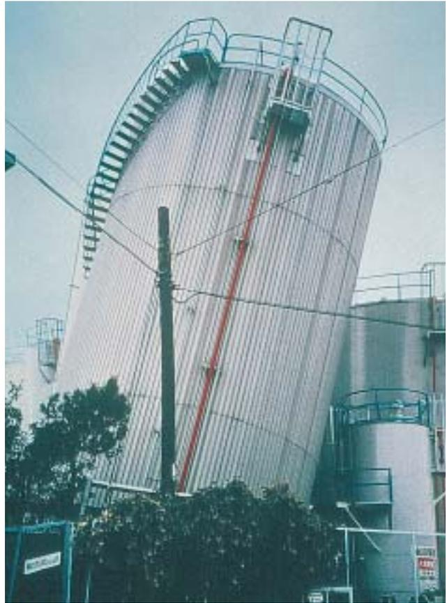
30/4 Ce réservoir s'est également incliné. Il s'est avéré que le mouvement était dû à la liquéfaction d'un remblai sableux (Kobe, Japon, 1995).
