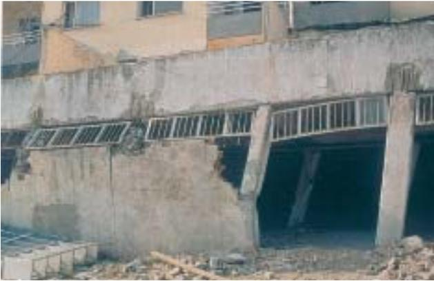
17/4 Dans ce cas, la combinaison de murs en maçonnerie et de fenêtres continues a également provoqué d'importantes sollicitations, d'où rupture des colonnes de cadres. La colonne massive de droite qui s'est relativement bien comportée a contribué à éviter – de justesse – que le bâtiment ne s'effondre.
