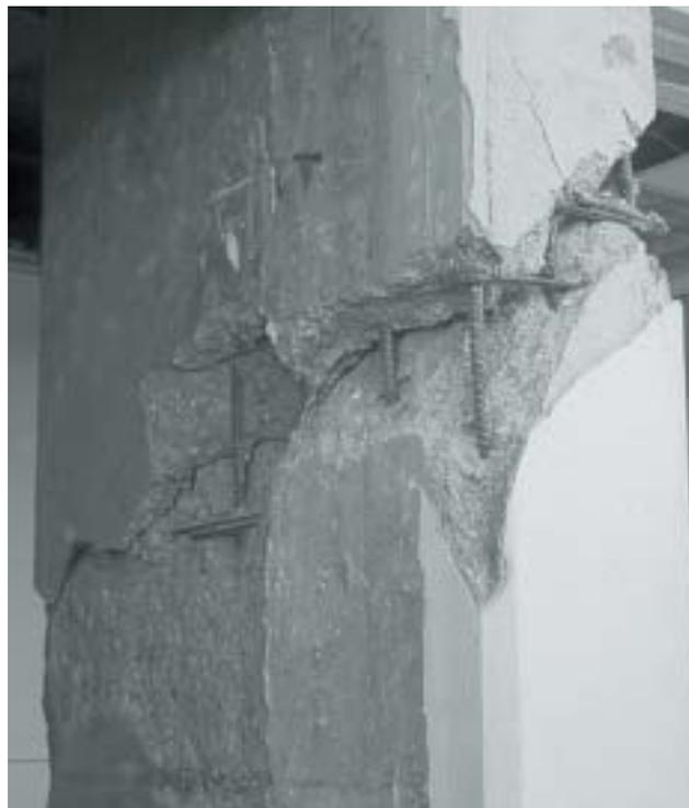
17/3 Une armature transversale mieux conçue (étriers et barres de liaison à intervalles rapprochés) aurait probablement permis d'éviter la rupture de la colonne par effort tranchant. Cependant, la source du problème réside dans le remplissage partiel du cadre, qui a provoqué le phénomène de colonne courte (Izmit, Turquie, 1999).
