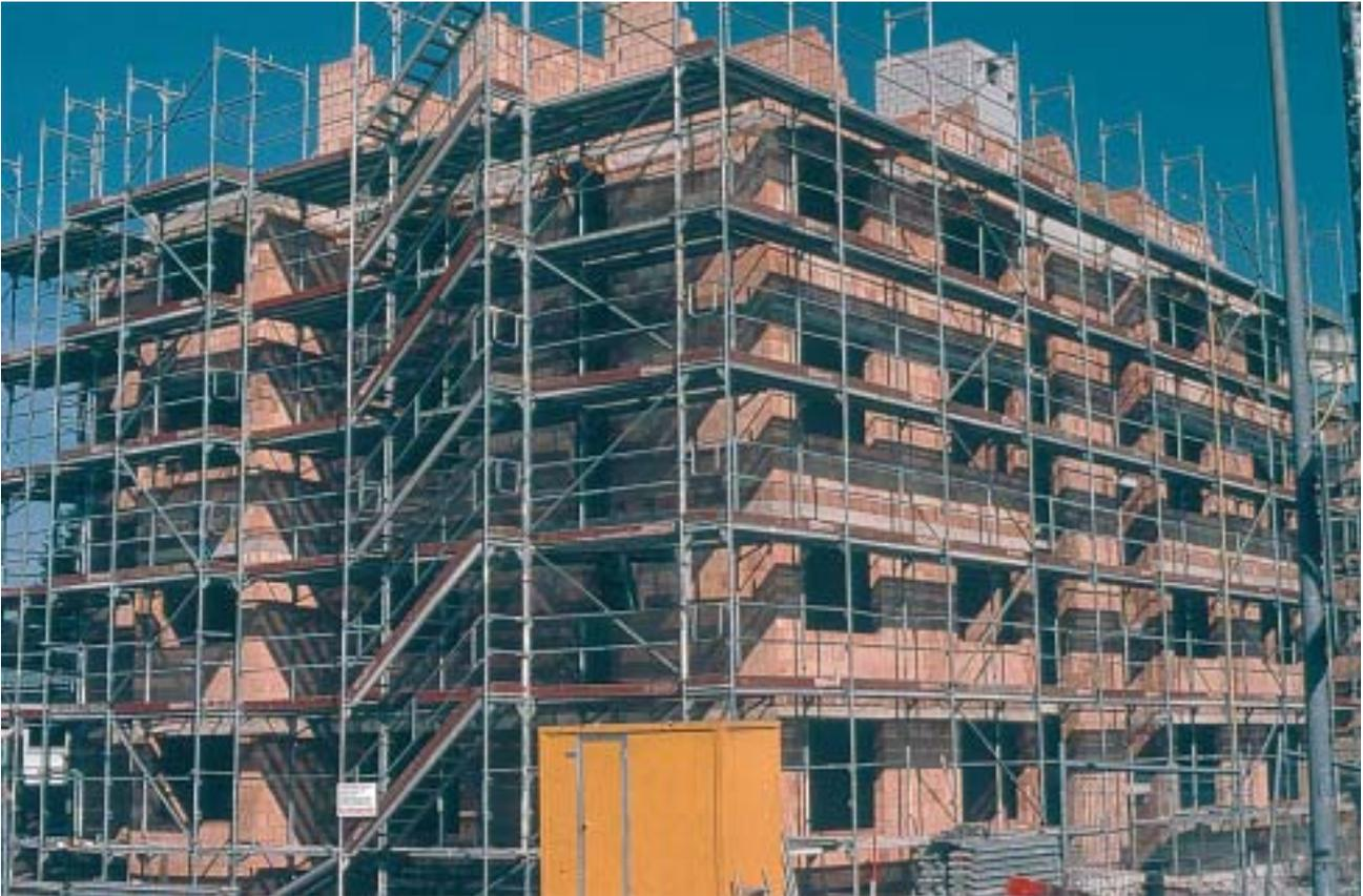
2/1 On construit encore des ouvrages sans vérifier s'ils présentent une tenue au séisme suffisante au sens des normes en vigueur. Dans le cas de ce bâtiment en maçonnerie, il semble qu'aucune mesure adéquate n'ait été prévue (p. ex. contreventement en béton armé). Une tenue au séisme insuffisante est de nature à occasionner une importante dépréciation de l'ouvrage, source de procès en responsabilité civile (Suisse, 2001).
