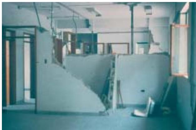
14/1 Dans ce cas, les cloisons non-porteuses ont été détruites, bien que la structure en cadre ait subi des déformations et des dégâts mineurs, et que les fenêtres soient restées intactes (Arménie, 1988).
