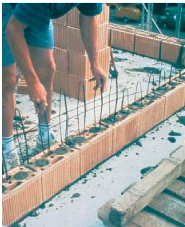
13/1 13/2 Pour armer la maçonnerie, il faut utiliser des briques spéciales, qui permettent notamment de disposer les armatures verticales et de les enrober avec du mortier. A l'heure actuelle, des études sont menées dans le monde entier pour développer des systèmes d'armature et des briques appropriées. Les deux figures présentent des produits récemment mis au point par l'industrie de la terre cuite (Suisse, 1998).
