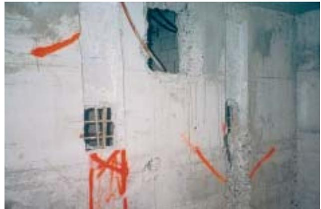
26/1 La conception de cette paroi parasismique a été annihilée par l'insertion d'installations dans le coffrage, l'ouverture de gros trous et la coupure sans ménagement de fers d'armature.
