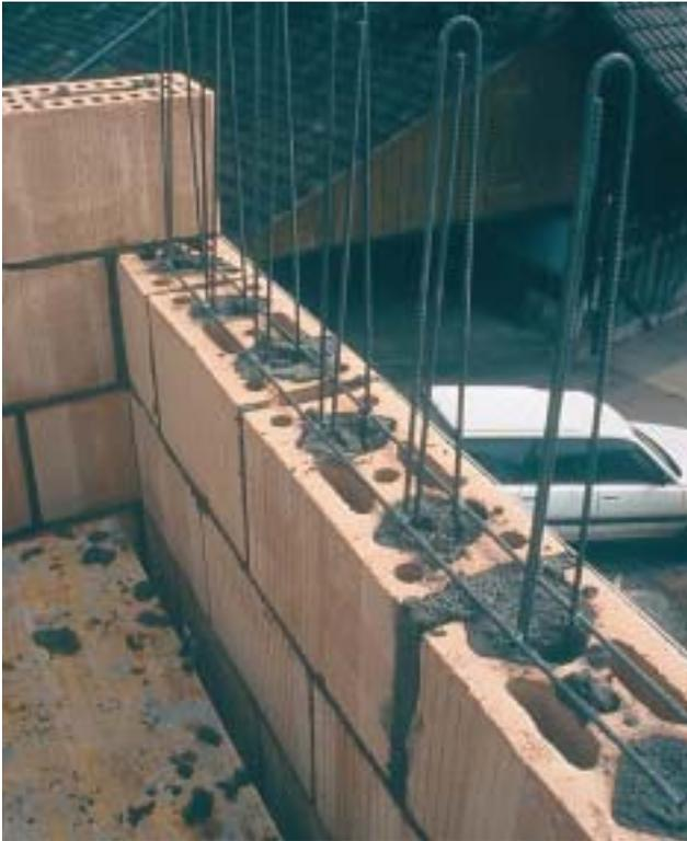
13/3 Pour ce type d'armature, les fers verticaux se terminent en haut et en bas par des boucles qui se prolongent sur 2 rangs de briques. Les fers de liaison servant à fixer les parois aux dalles, respectivement aux parois inférieures, revêtent une grande importance (Suisse, 1998).
