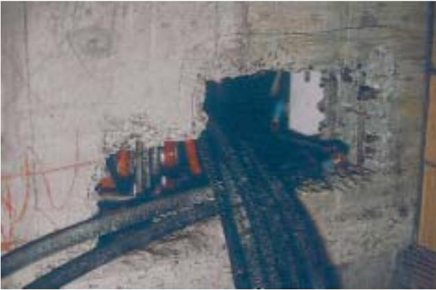
26/3 Ici, on a percé un trou – beaucoup trop gros – à travers l'armature. Or on aurait peut-être pu pratiquer, d'entente avec l'ingénieur, une ouverture notablement plus réduite sans endommager l'armature. Pour y parvenir, il faudrait commencer par regrouper les conduits et les faire passer perpendiculairement à la paroi.
