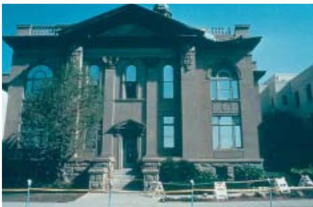
33/1 Ce bâtiment de style néo-classique en béton armé n'a pas subi de gros dégâts. Même les vitres sont restées intactes. Cependant, la balustrade a partiellement basculé sur un côté de la terrasse sur le toit...
