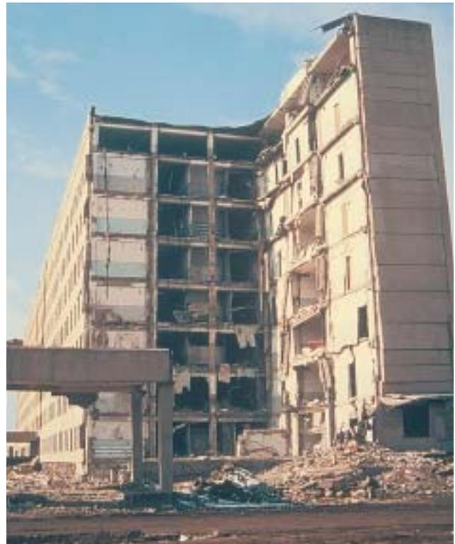
22/1 Un angle de ce bâtiment s'est effondré. Les dalles se composaient seulement d'éléments préfabriqués sans béton armé de couverture ni liaison armée avec les éléments porteurs verticaux (Arménie, 1988).
