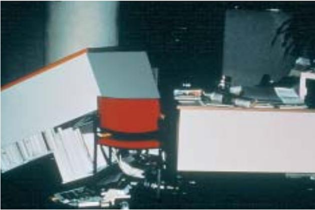
35/4 Les armoires de classement risquent de basculer, surtout si les tiroirs à roulettes ne sont pas retenus par des dispositifs adéquats (Morgan Hill, Californie, 1984).
