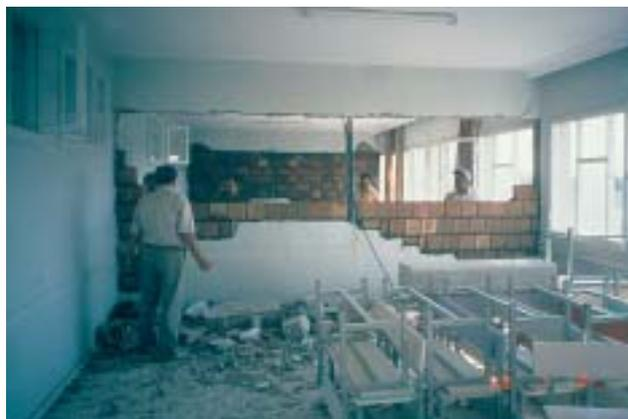
14/2 La cloison détruite est à nouveau construite en maçonnerie, jusqu'au prochain tremblement de terre... (Adana-Ceyhan, Turquie, 1998).
