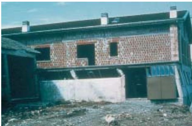
17/1 Dans ce cas, le remplissage partiel du cadre a provoqué le phénomène de colonne courte. Comme les étriers étaient judicieusement disposés, il n'y a pas eu de véritable rupture par cisaillement, mais il s'est produit un mécanisme de colonnes captives, tout aussi dangereux (Frioul, Italie, 1976).
