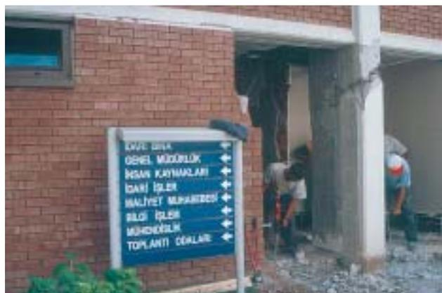
17/2 A gauche de la colonne brisée se trouvait une embrasure de fenêtre semblable à celle du bord gauche de la photo. Le mur en maçonnerie – écroulé – qui se trouvait sous l'embrasure remplissait partiellement le cadre. Il s'est déplacé vers la droite, poussant la colonne et provoquant son cisaillement.
