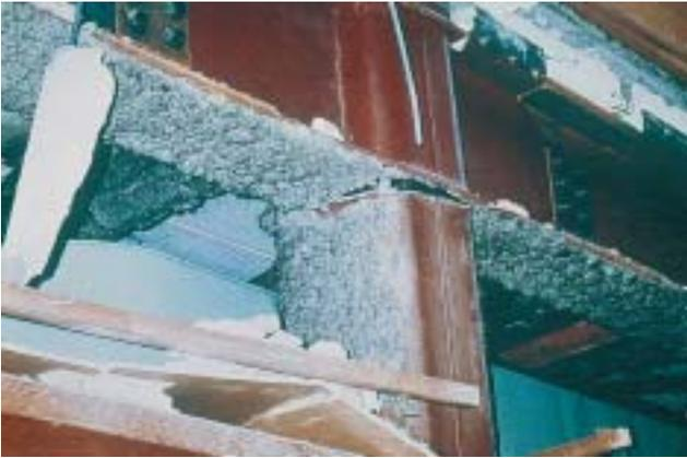
19/3 Cette photo présente une rupture au nœud d'un cadre. La soudure de liaison entre la colonne et la poutre a cédé, laissant la place à une large fissure (Kobe, Japon, 1995).
