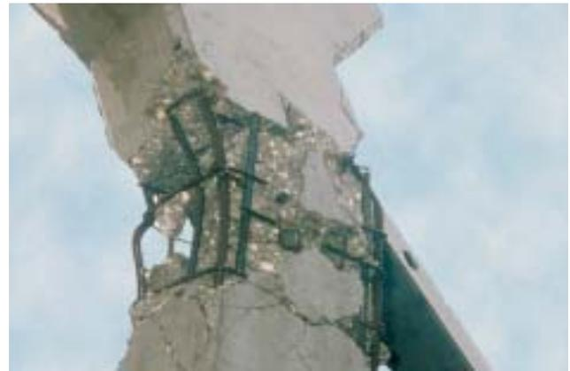
25/1 Dans cette colonne de halle constituée d'éléments préfabriqués en béton armé, les étriers étaient insuffisamment ancrés, avec des crochets à  $90^\circ$  seulement. C'est pourquoi ils se sont ouverts, permettant aux barres verticales de flamber (Adapazari, Turquie, 1999).
