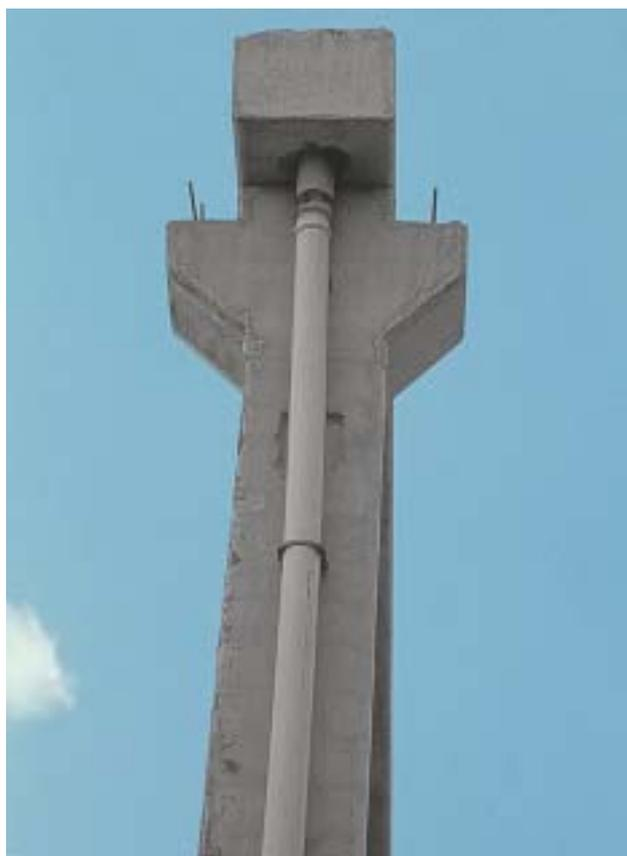
27/1 Les corbaux équipant les colonnes d'une halle de fabrique en éléments préfabriqués comportaient certes des goujons, mais les dispositifs anti-déversement étaient lacunaires. Les appuis ayant cédé, les poutres principales ont basculé et sont tombées au sol (selon une direction parallèle à l'axe longitudinal de la halle)...
