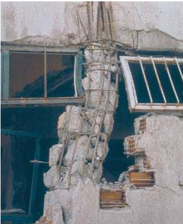
17/5 Cette colonne présente des défauts d'exécution (étriers avec crochets recourbés à 90° au lieu de 135°, d'où rupture des ancrages; cf. PB 25). Mais sans l'effet néfaste des murs de remplissage, cette colonne se serait bien mieux comportée (Izmit, Turquie, 1999).
