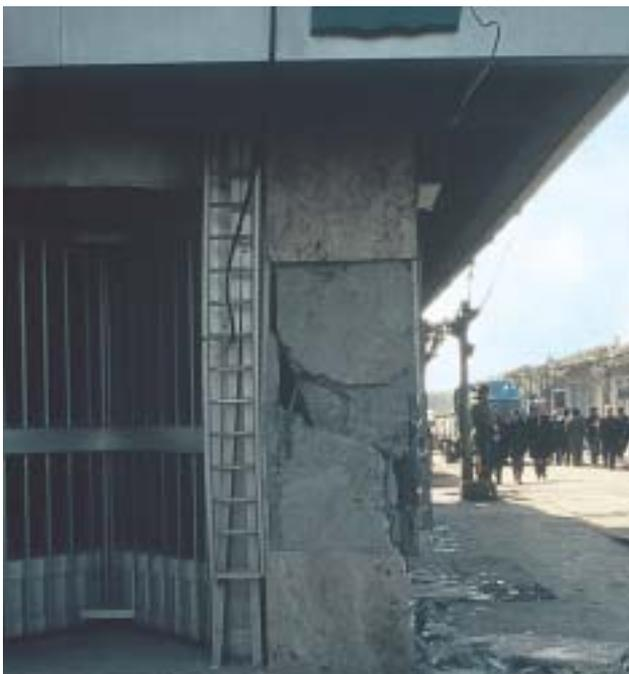
16/3 La rupture par effort tranchant des colonnes d'angle trapues équipant le rez-de-chaussée de cet immeuble commercial a également failli provoquer son effondrement (Erzican, Turquie, 1992).
