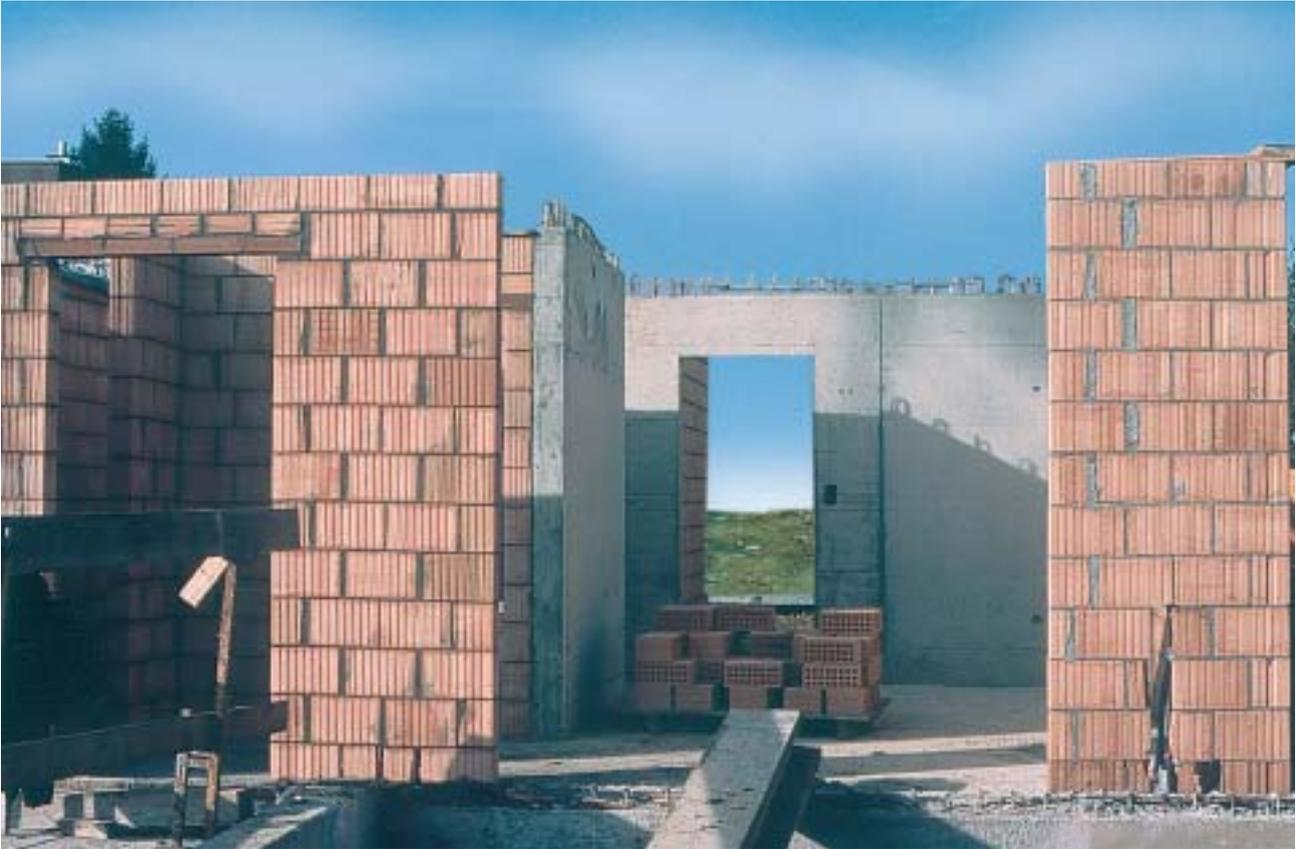
12/3 Ce bâtiment en maçonnerie, qui comprendra quatre étages, est renforcé par une paroi porteuse en béton armé dans chaque direction principale. Une longue paroi en maçonnerie, dont les joints d'assise sont pourvus d'une armature ancrée dans les parois porteuses en béton armé, équipe également chaque direction (Suisse, 2001).
