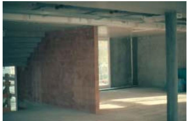
10/1 Il suffira d'un modeste tremblement de terre pour détruire la cage d'escalier porteuse, ce qui pourrait bien provoquer l'effondrement du bâtiment (Suisse, 2001).
