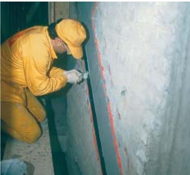
13/7 Les lamelles doivent être soigneusement collées et ancrées dans les dalles (Suisse, 1997).
