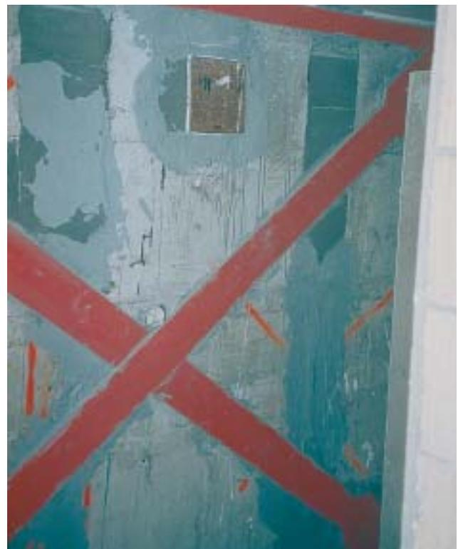
26/2 Des réparations onéreuses, consistant à remplir soigneusement les ouvertures avec du béton expansif et à coller et ancrer des lamelles d'acier en forme de treillis, ont permis de retrouver la résistance ultime de la paroi parasismique. Cependant, il est presque impossible de recouvrer le comportement ductile autorisé par l'armature d'origine (Suisse, 2001).
