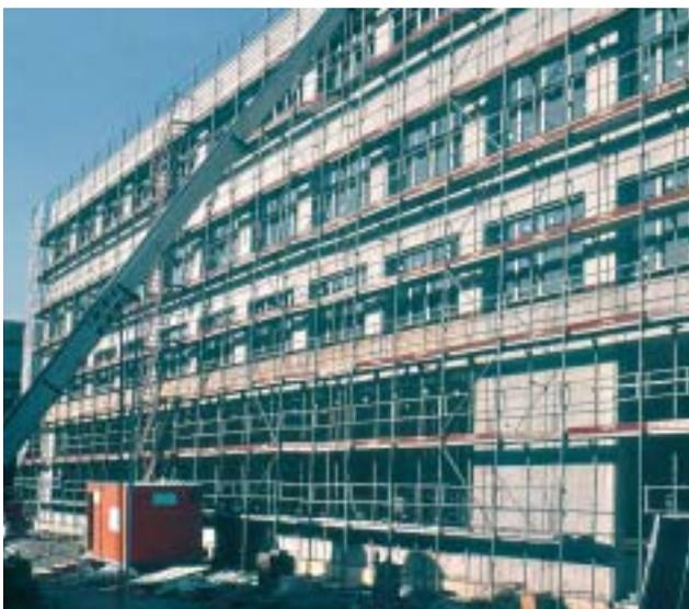
8/1 Le passage de la paroi porteuse en béton armé à un système en ossature occasionne de gros sauts de rigidité et de résistance (Suisse, 2001).
