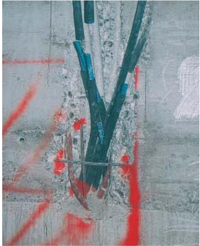
26/5 Insérés sans planification dans une paroi porteuse en béton armé, de tels écheveaux sont également susceptibles de nuire aux caractéristiques parasismiques du mur (Suisse, 2001).
