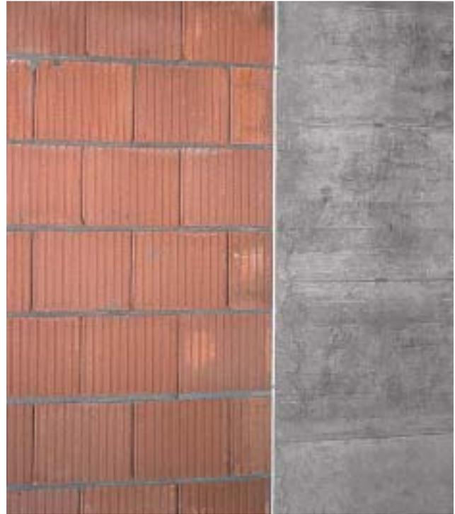
15/3 Ce joint, disposé entre une paroi en maçonnerie et une paroi porteuse en béton armé, est rempli par des plaques de mousse dure. Ce matériau est trop rigide pour les déplacements engendrés par les tremblements de terre. Le caoutchouc, par exemple, est préférable (Suisse, 1994).
