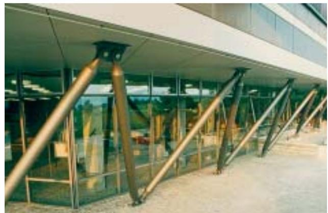
6/6 Le nouveau treillis en tubes d'acier s'insère dans le bâtiment existant sans en altérer l'esthétique.
