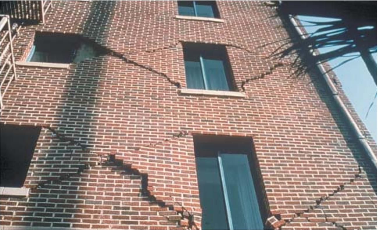
32/3 Ce revêtement de façade était insuffisamment ancré et ne concordait pas avec les déformations prévisibles de la structure porteuse, formée de cadres en béton armé (Northridge, Californie, 1994).
