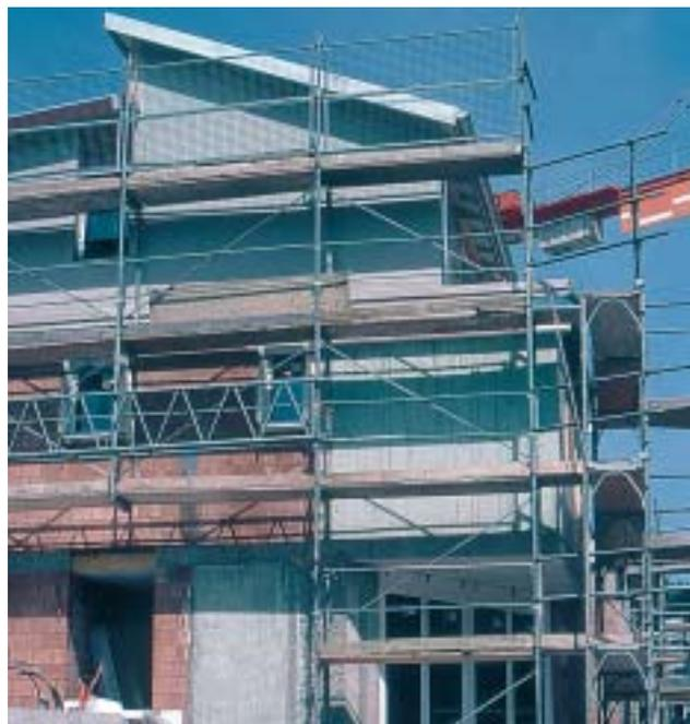
7/1 Le décalage horizontal des parois en béton armé dans le plan de la façade génère d'importantes sollicitations et déformations dans la structure porteuse lors de tremblements de terre. Il s'agit d'efforts locaux verticaux (résultant du moment renversant), d'efforts tranchants affectant les dalles à la hauteur des décalages, de surcharges sur les fondations, etc. (Suisse, 2001).
