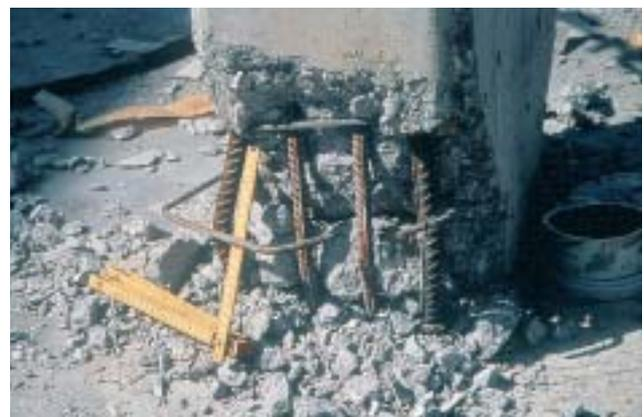
25/2 La photo de cette colonne de cadre montre également la rupture des ancrages des étriers, dont les crochets n'avaient qu'un angle de  $90^\circ$  (Izmit, Turquie, 1999).
