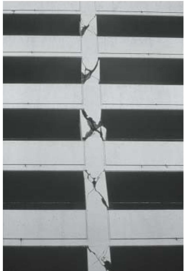
16/1 Les fissures en croix et les ruptures par effort tranchant qui ont affecté les colonnes courtes de ce parking ont presque entraîné son effondrement (Northridge, Californie, 1994).
