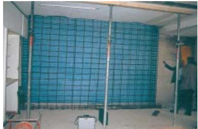
9/2 L'armature des parois porteuses en béton armé est relativement simple, mais elle doit être conçue et disposée avec grand soin. La figure présente une paroi ductile dimensionnée en capacité, de section rectangulaire, qui a été rajoutée dans un bâtiment existant (Suisse, 1999).
