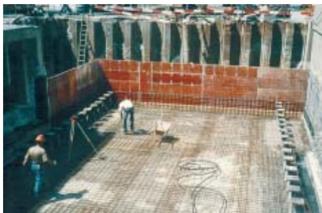
28/1 Sur ce chantier, il a fallu poser des tirants d'ancrage dans le sol pour empêcher que la fondation des parois porteuses en béton armé ductiles – qui doivent encore être bétonnées – ne risquent de se soulever (Suisse, 1999).
