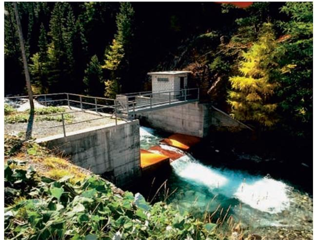
Fig. 4-16 : Station de jaugeage du Chamuerabach à La Punt-Chamues-ch.
