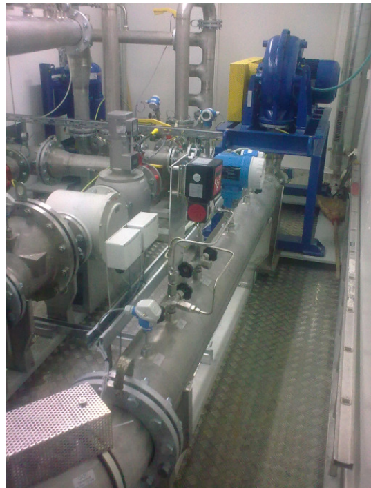
Abbildung 8: Prozessmesstechnik in der Absauganlage
