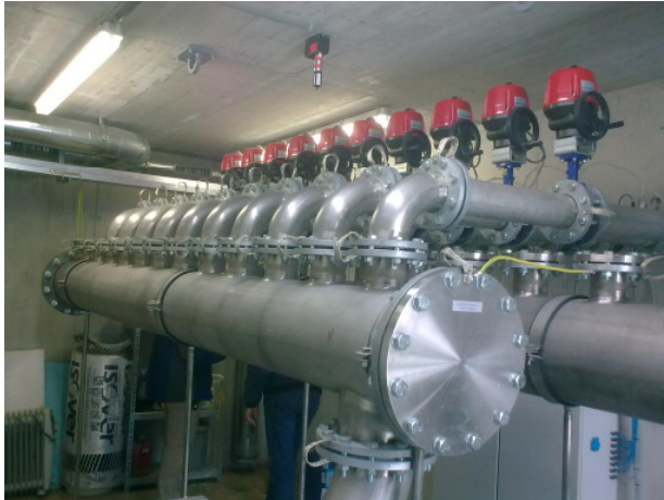
Abbildung 5: Sammelbalken der Anlagen 1 und 2
