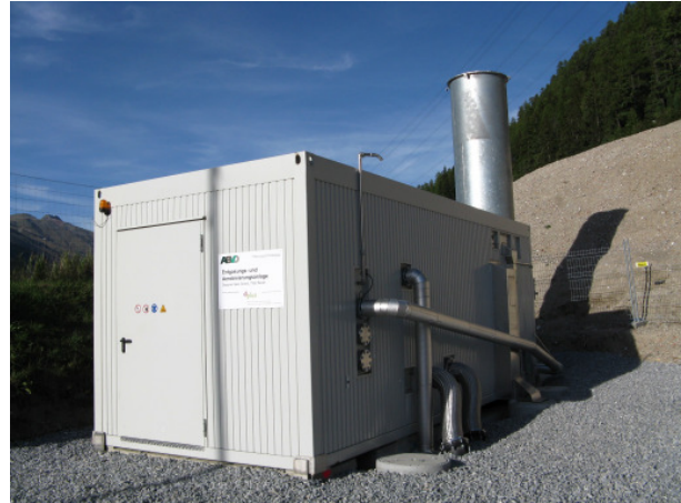
Abbildung 6: Absauganlage (Sass Grand)
