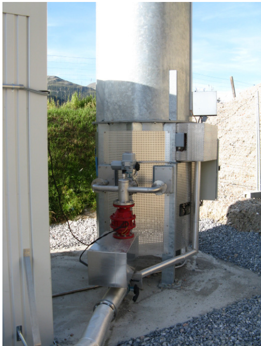
Abbildung 7: Hochtemperaturfackel in Sass Grand
