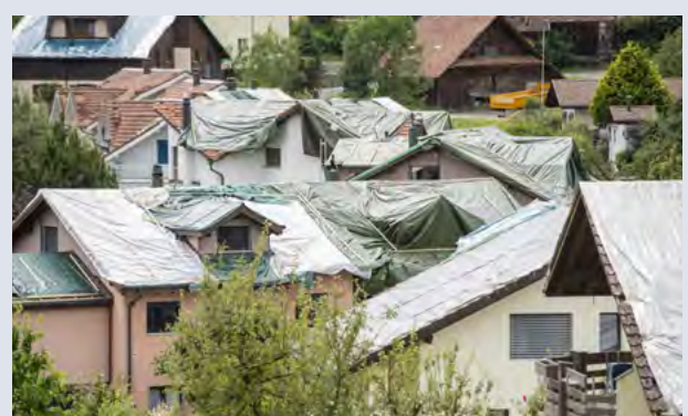
Une tempête de grêle a causé des dégâts importants le 28 juin 2021 à Wolhusen (LU). Photo : Urs Flüeler / Keystone
