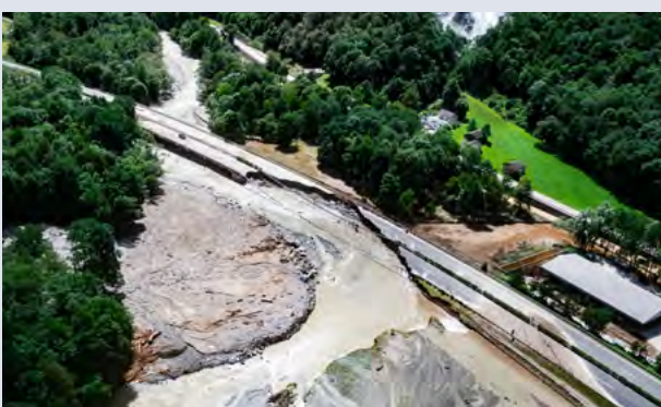
Partie de l'autoroute A13 détruite, entre Lostallo et Soazza (GR). Photo : Samuel Golay / Keystone / Ti-Press
