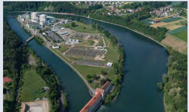
La centrale nucléaire de Beznau (AG) est refroidie par l'eau prélevée dans l'Aar. Réchauffée, l'eau est ensuite rejetée dans la rivière, ce qui peut représenter un danger pour l'écosystème en été. Photo : Urs Hubacher / Keystone
