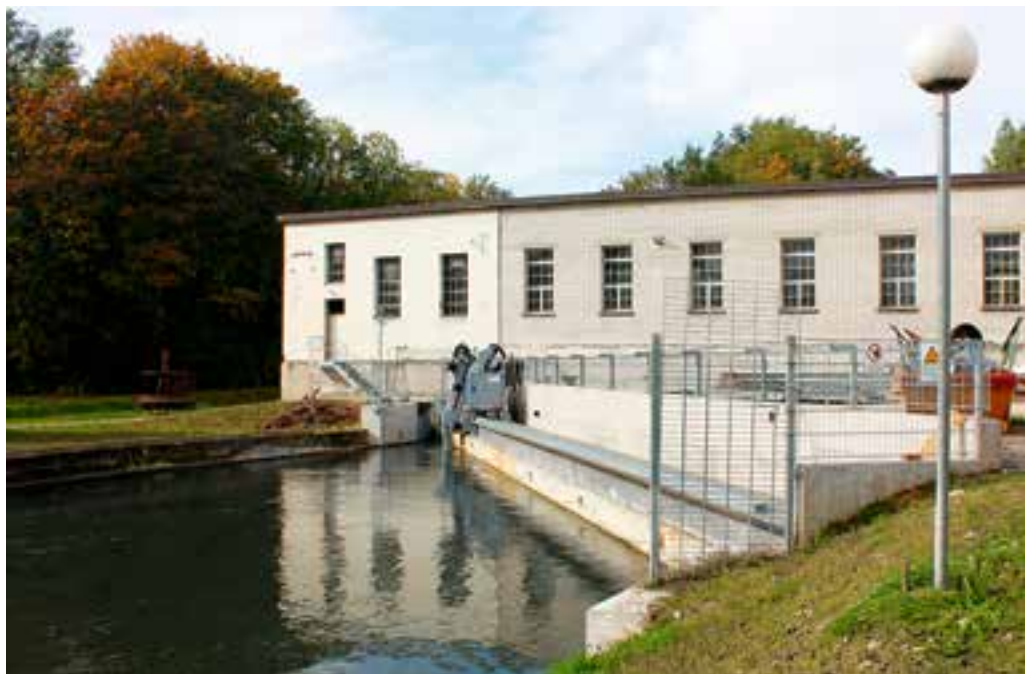
La centrale hydraulique de Stroppel dispose d'une grille fine qui permet aux poissons de contourner les turbines lors de leur dévalaison.
