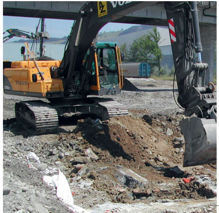
Assainissement d'un site contaminé à Rothenburg (LU): le sous-sol de cette ancienne aire de production, de stockage et de transbordement est contaminé par des hydrocarbures. On voit ici le triage des matières excavées, qui seront entreposées provisoirement en attendant la suite du traitement, en l'occurrence le nettoyage du sol et l'élimination.
