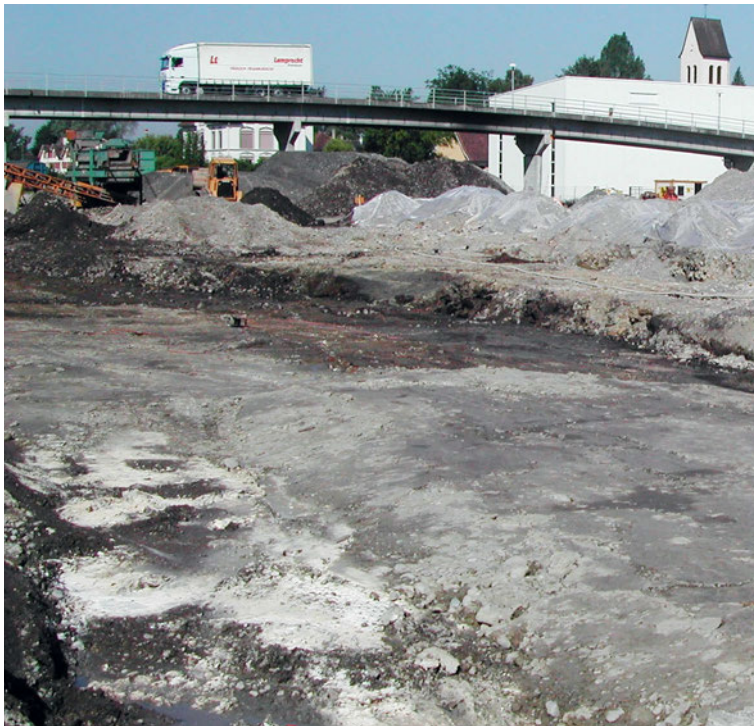
Assainissement d'un site contaminé à Rothenburg (LU): le sous-sol de cette ancienne aire de production, de stockage et de transbordement est contaminé par des hydrocarbures. On voit ici le triage des matières excavées, qui seront entreposées provisoirement en attendant la suite du traitement, en l'occurrence le nettoyage du sol et l'élimination.
