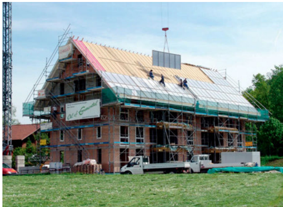
Jenni Energietechnik AG, Berthoud
