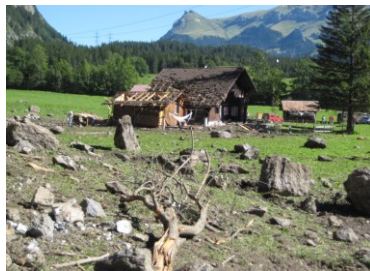
Steinschlag Hellhore, Kandersteg 2008 Chutes de pierres et de blocs
