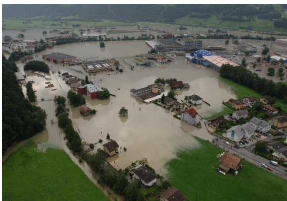
Fig. 1: Inondation à Schattdorf (UR) causée par la Reuss, le Schächenbach et le Gangbach, août 2005 (Source: Canton d'Uri)
