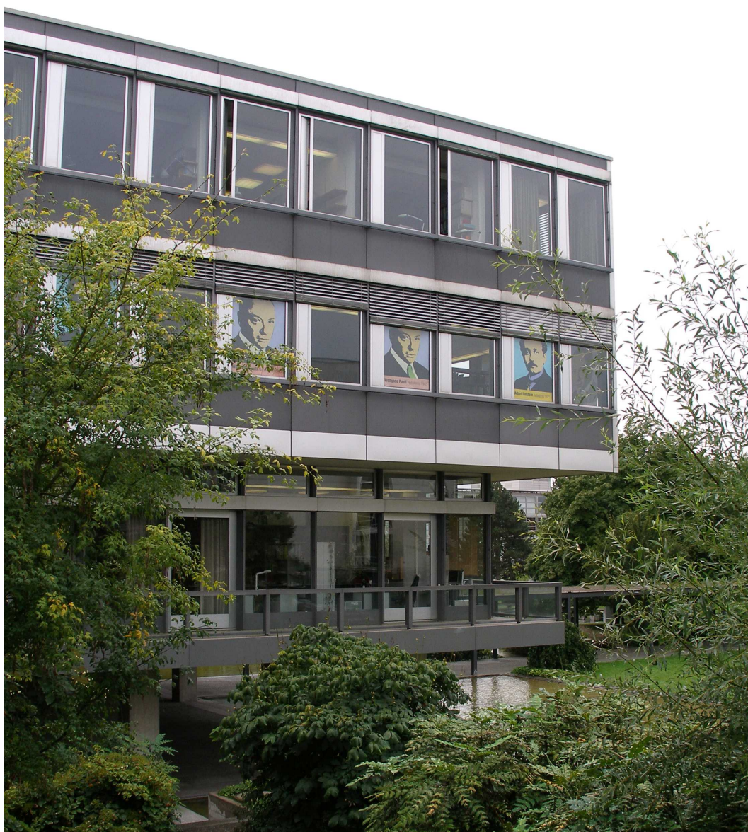
Figure E1: Bâtiment exemple, vue due nord-est
