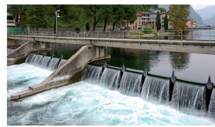
Le barrage de régulation de Ponte Tresa comprend trois vannes de dévalaison de 14 m de largeur manœuvrées par des cylindres. La différence moyenne entre les niveaux en amont et en aval du barrage varie entre 1,5 et 2,0 m.
