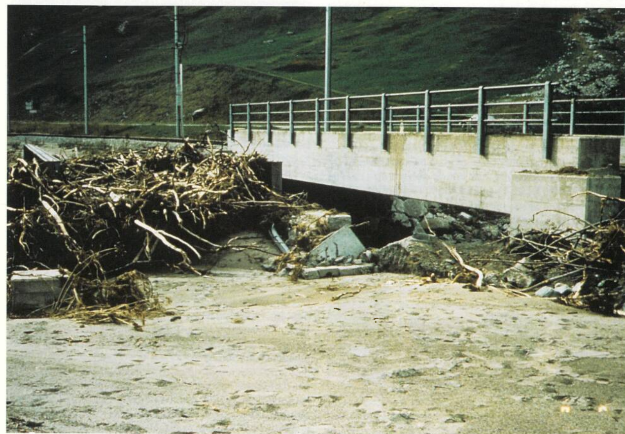
Photo 10: Les phénomènes de reflux ne sont pas seulement engendrés par des matériaux qui se déposent, mais aussi par des voutages obstrués. Les embâcles peuvent être provoquées par des bois ou par des matériaux charriés; on assiste la plupart du temps à une combinaison des deux.
