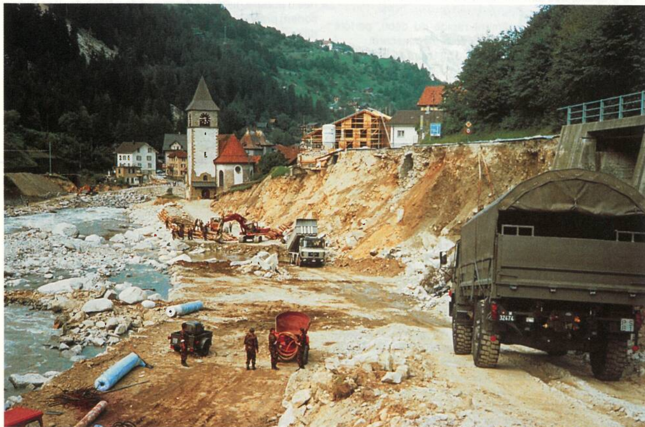
Photo 17: Erosion latérale de la rive de la Reuss à Gurnellen. On a tendance à considérer comme équivalents les dangers liés aux crues et ceux dus aux inondations. La cure de Gurnellen s'est effondrée dans la rivière à cause de l'affouillement de ses fondations.
