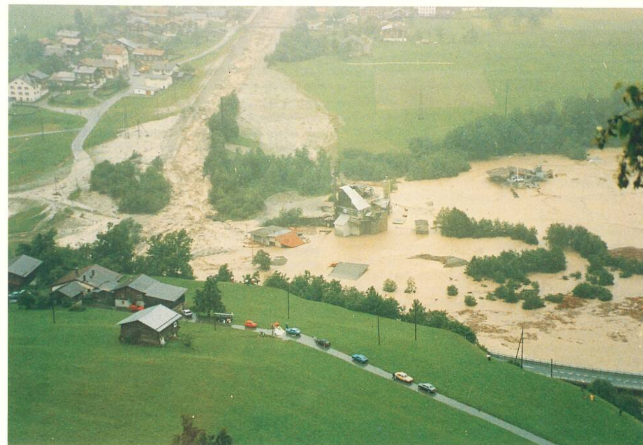
Photo 9: La lave torrentielle de la Zarvagia a eu pour conséquence une surélévation du niveau de l'eau dans le Rhin, consécutive aux dépôts de matériaux. Le Rhin coula momentanément dans le tunnel des Chemins de fer rhétiques. Ces dégâts sont typiques des laves torrentielles qui atteignent le cours d'eau principal.
