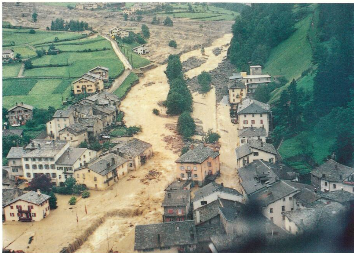
Photo 3: Poschiavo, le pont de Cimavilla. Le ponceau a été obstrué par les matériaux charriés. La rivière déborda et chercha un nouveau chemin.
