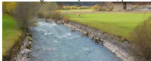
Aménagement imperméable, pentu, linéaire
