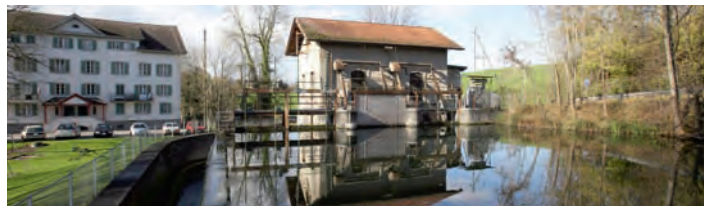
Petite centrale sur la Lorze, à Cham (ZG).
