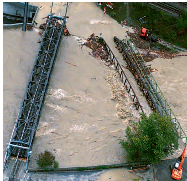
En 2000, une crue a provoqué des dégâts considérables dans la vallée du Rhône. A gauche: plan d'assainissement du fleuve pour le tronçon 5 (région de Brigue). Photo: Keystone
