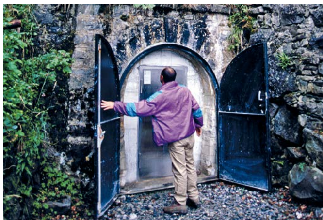
Réservoir d'eau, Altdorf-UR
